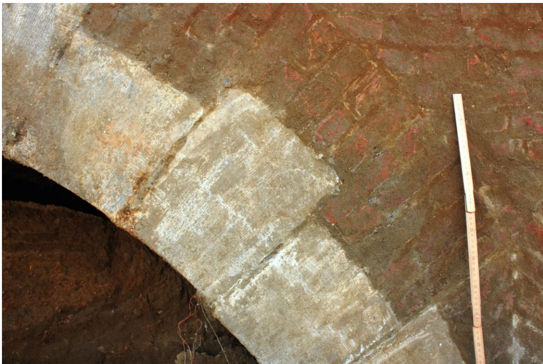
Fig. 10: Detail van de omlijsting van de rondbogen. (foto: Onroerend Erfgoed)
