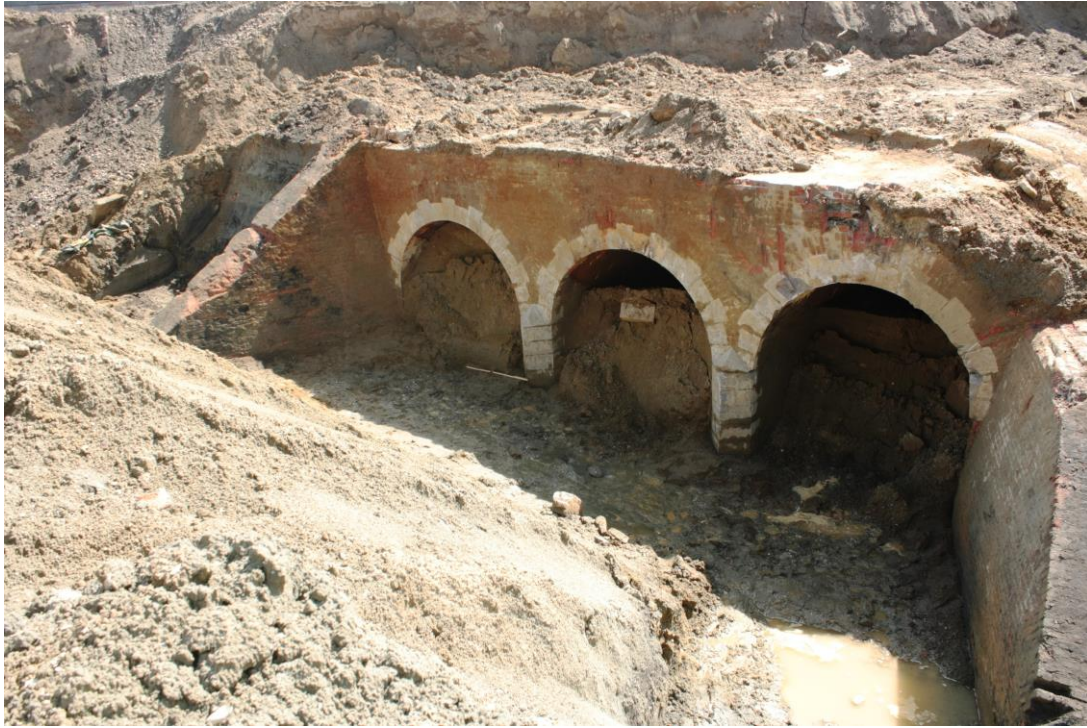
Fig. 9: Het noordoostelijke uiteinde van de sluis, met de drie rondbogen en keermuren. (foto: Onroerend Erfgoed)
