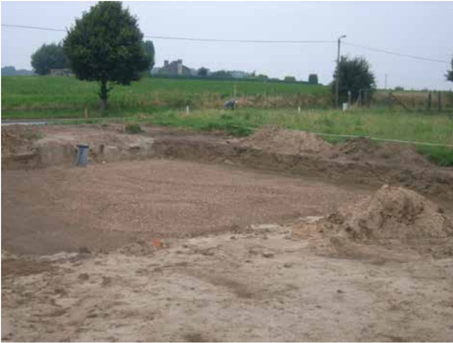
Figuur 3 Zicht op de bouwput vanuit het oosten.
