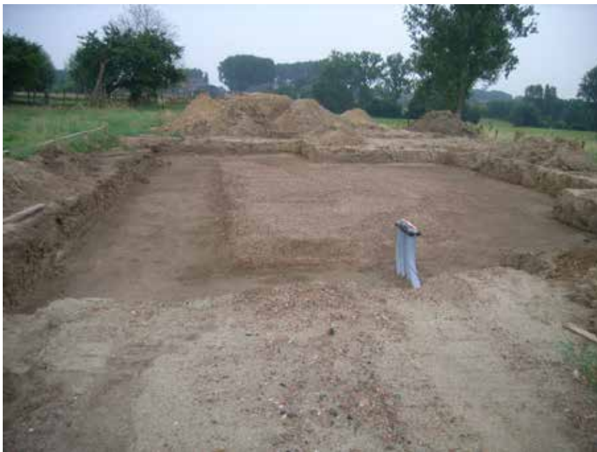
Figuur 2 Zicht op de bouwput vanuit het westen.
