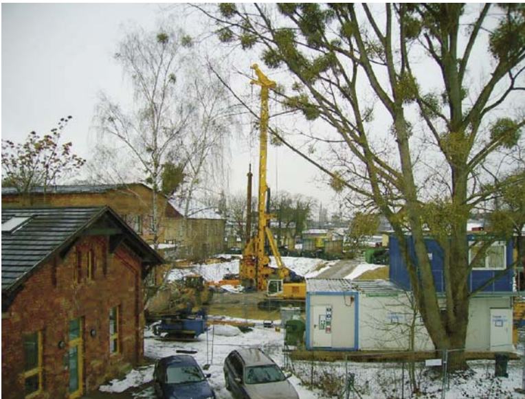
Abb. 7: Einsatz des Großbohrgerätes zum Bodenaustausch
