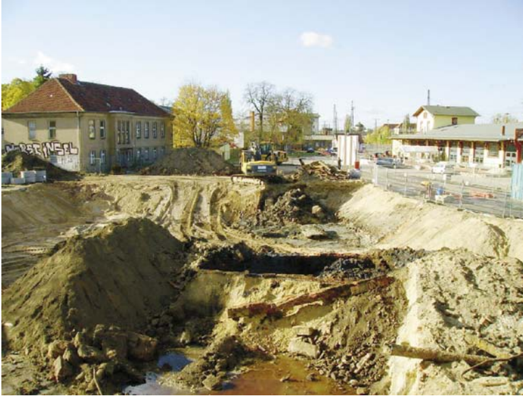
Abb.6: Baugrube mit Resten der Teergrube
