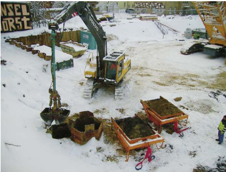
Abb. 8: Einrütteln einer Wabe zum Bodenaustausch
