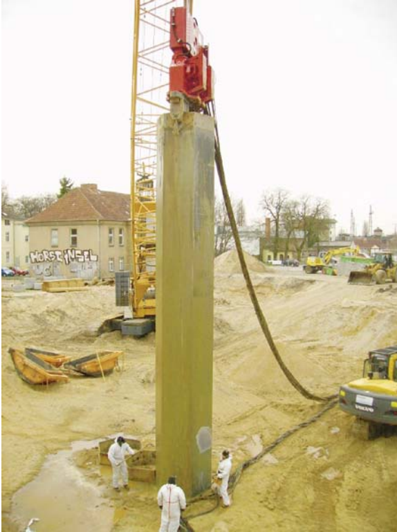
Abb. 8: Einrütteln einer Wabe zum Bodenaustausch
