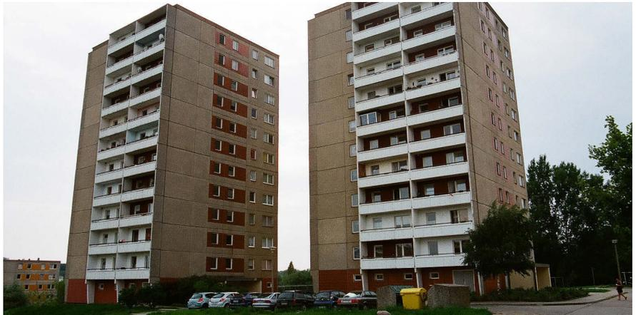
Abb. 2: DDR-Plattenspendergebäude, Typ PH 12, Frankfurt/Oder (Foto: zukunftsgerausche)
