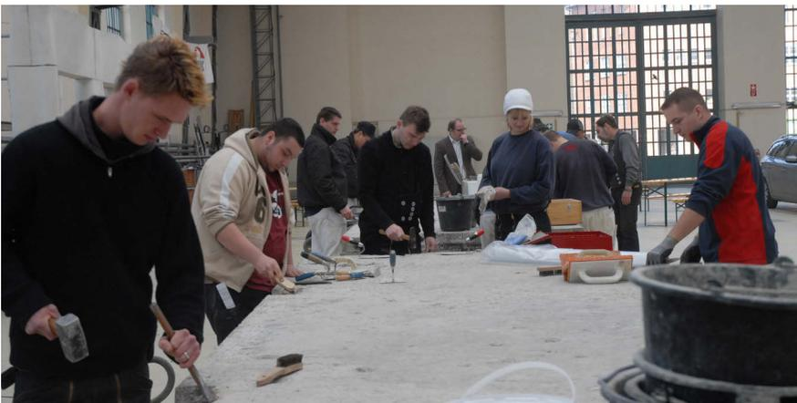
Abb. 6: Lehrbaustelle Phase 1: Aufarbeiten von demontierten Betonfertigteilen (Foto: zukunftsgeraeusche)
