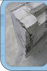
Die augenscheinliche Überprüfung der Betonelemente nach Rissen erfolgt in der Regel kurz nach der Anlieferung und nach dem Einbau. Die Ergebnisse werden in einem Kontrollplan protokolliert.
