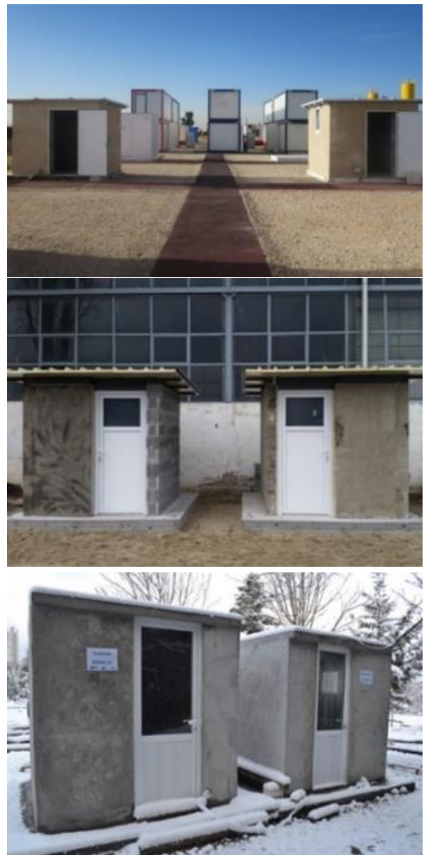
Figure 7. Three demo-sites installed in Europe (Spain, Romania and Turkey) using SUS-CON prefabricated components and ready-mixed concretes / Tre edifici pilota installati in Europa (Spagna, Romania e Turchia) realizzati con elementi prefabricate e calcestruzzi pre-miscelati SUS-CON.
