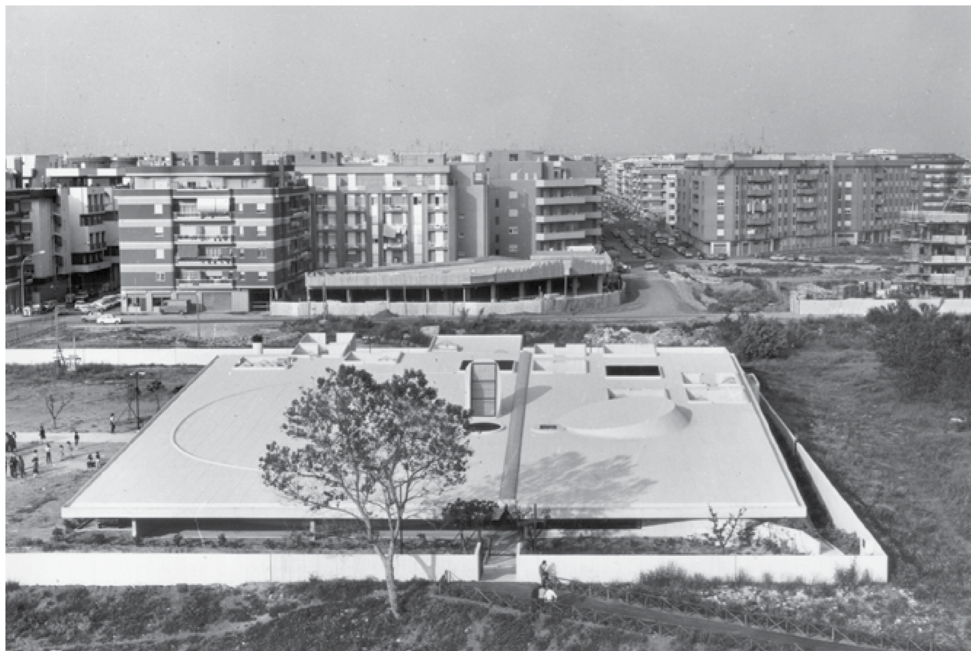
fig. 1 - L'edificio nella versione realizzata nel contesto del quartiere ancora in completamento, inizio anni '80 (Archivio Studio Berarducci)
