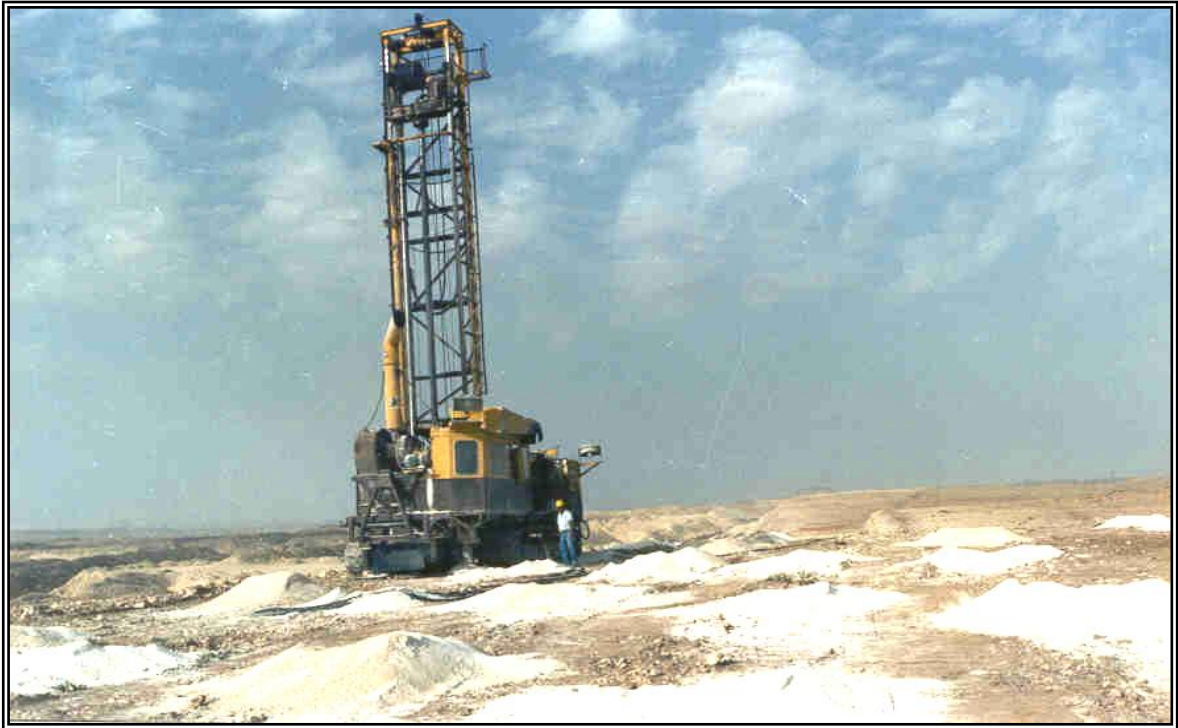
Fig.37: Perforazione del terreno per mezzo di trivelle elettriche. Fonte: Direction des Exploitations Minières de Khouribga-Division Gestion Administrative et Sociale, MNK/AK/S, Rapport de stage, Aprile 2010, p.14
