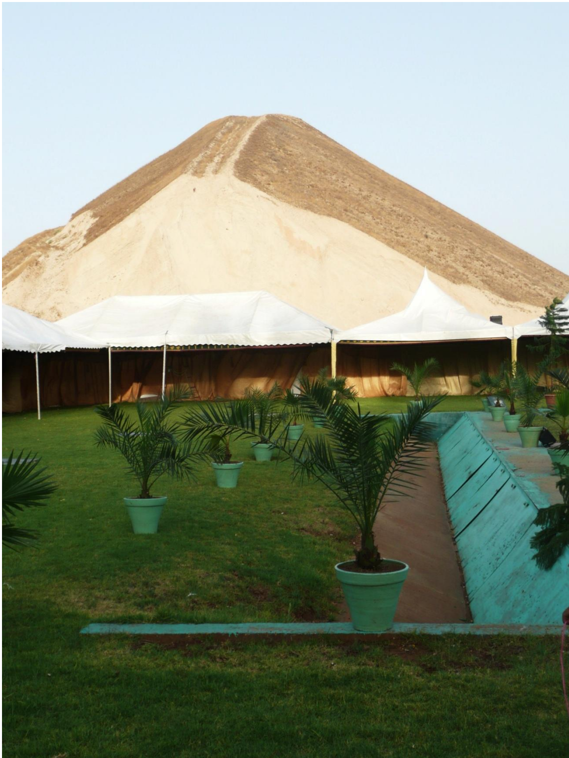
Fig.51: Tentativo di recupero di un impianto di trattamento in disuso. Hattane. (Foto L.Bianco, Hattane, luglio 2010)
