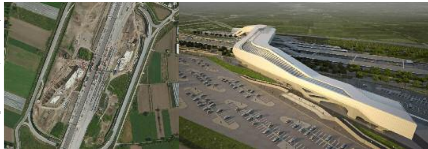
STAZIONE PORTA NAPOLI_ZAHA HADID AFRAGOLA_ PROGETTO 2003 (CANTIERE 2012)
