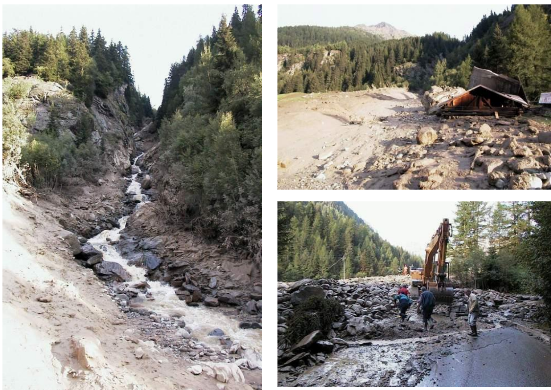
Figura 6.4: a) zona interessata dalla colata detritica; b) fienili distrutti dalla colata; c) interruzione della strada comunale ( http://edit.protezionecivile.tn.it/ )
