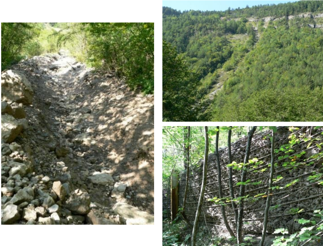
Figura 6.52: a) canale di scorrimento; b) versante interessato dalla frana; c) barriere paramassi sommerse dai detriti ( http://edit.protezionecivile.tn.it/ )
