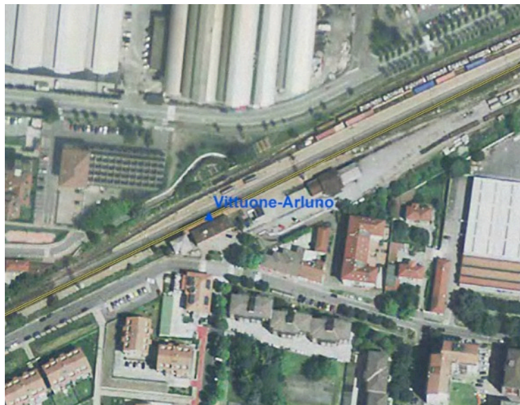
Figura 85 - Stazione ferroviaria di Vittuone - Arluno.
