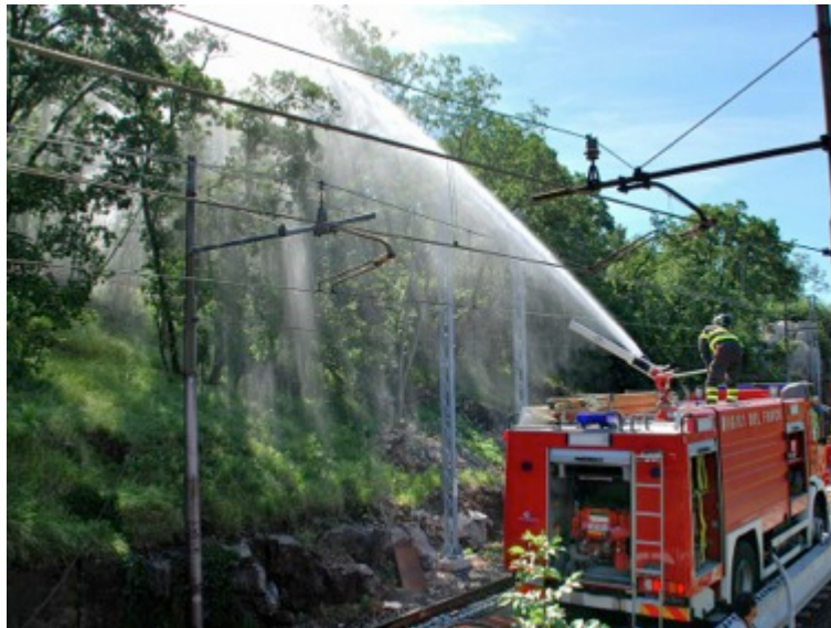
Figura 69 - Utilizzo di APS su pianale ferroviario.
