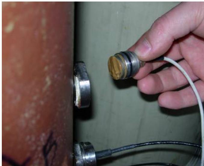
Figura 3.10. Messa in opera del tensiometro
