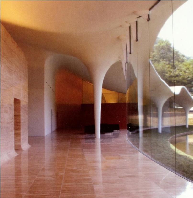
I pilastri di sostegno della copertura, che proseguono direttamente la forma della copertura rastremandosi verso il basso, accolgono al loro interno anche il sistema di smaltimento delle acque meteoriche. Per realizzarli sono state utilizzate speciali casseforme prefabbricate e assemblate in opera.
