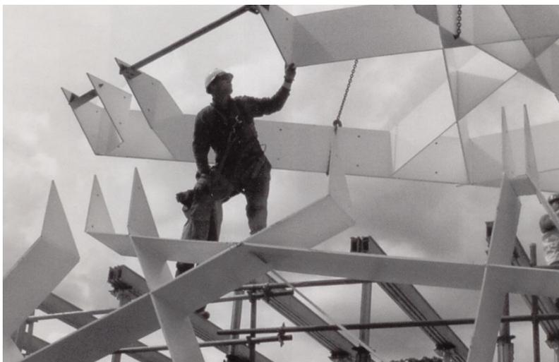
Il progetto di una struttura così complessa, naturalmente, ha riguardato anche la fase costruttiva che si è svolta per metà in fuori opera in un'acciaiera di Manchester e per metà *in situ*.
