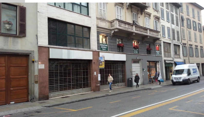
DISMISSIONE COMMERCIALE IN VIA ZAMBONATE – RILIEVO FEBBRAIO 2016
