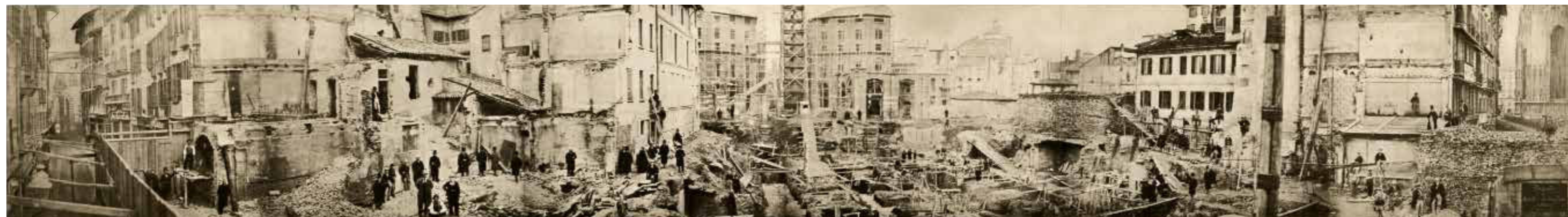
27. Panoramica con vedute accostate del cantiere della Galleria Vittorio Emanuele II, gennaio 1866, fotografia Deroche & Heyland, CAFMi FM A 747
