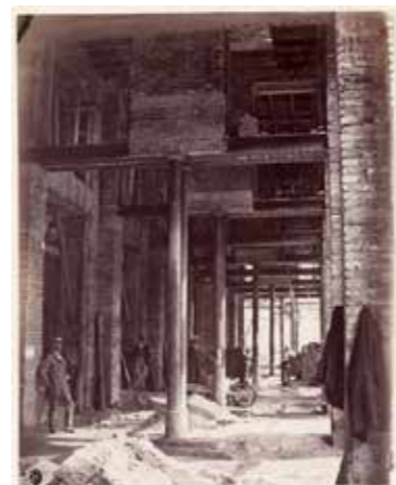
31a-b. Colonnine in ghisa e travi in ferro al piano terreno della Galleria Vittorio Emanuele II, fotografie Deroche & Heyland, 1866, CAFMi Albo G 107/23-24
