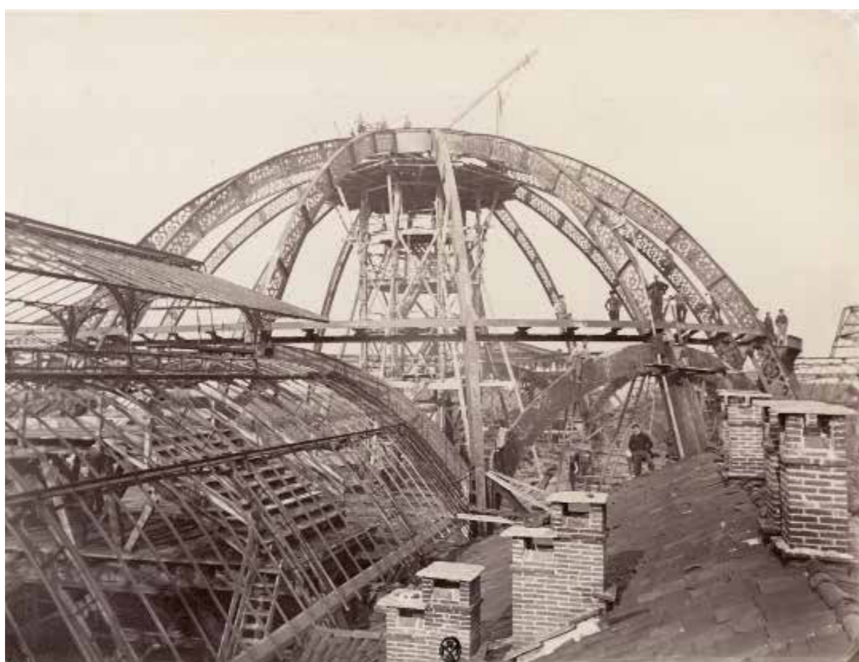
34. Posa dei vetri sulla copertura in ferro della Galleria Vittorio Emanuele II, fotografia Deroche & Heyland, marzo-maggio 1867, CAFMi Albo G 107/35
