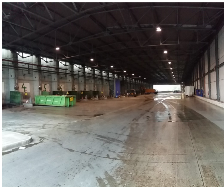
Figura 5 – Piazzale di scarico: i carichi che hanno dato l'allarme vengono scaricati di fronte alla porta 2
