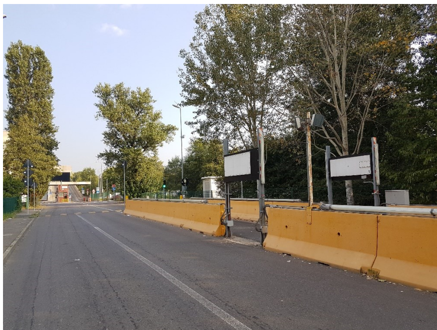
Figura 1 – Sistema radiometrico fisso in ingresso al Termovalorizzatore “Silla 2”
