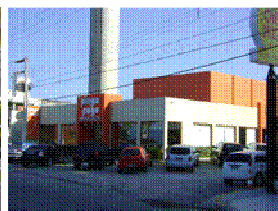
c) galpão decorado com pórtico
