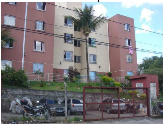
Figura 5: Vista das áreas de talude voltadas para a rua no conjunto Jardim Leblon.
