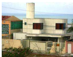
c) edifício modernoso
