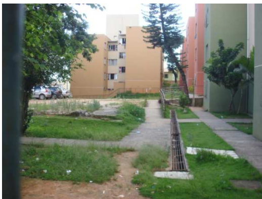
Figura 19: Espaço interno, onde havia o casarão, do conjunto Jardim Leblon; Fonte: Laboratório da Paisagem. 2013.
