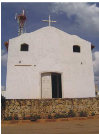
Figura 8: Igreja do bairro Alto da Torre. Fonte: Acervo particular da autora, 2006.
