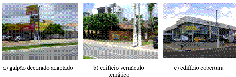
Figura 26: Tipos edifícios mais recorrentes no trecho 02. Fonte: visitas de campo.
