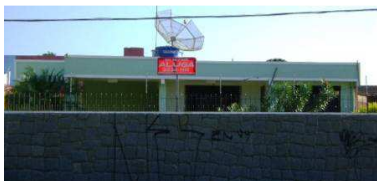
c) Residência tipo A reformada.
