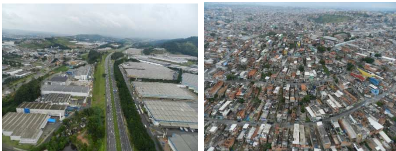
Figura 1 (esq) – Galpões industriais e de logística ao longo da Rodovia Presidente Castelo Branco, no município de Jandira. Figura 2 (dir) – Casario horizontalizado de baixa renda no município de Jandira. Fotos do autor, 2012
