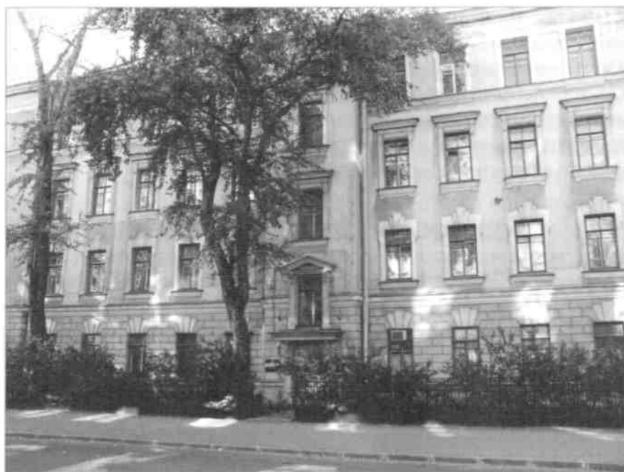
Здание Музея Радиевого института в Санкт-Петербурге
