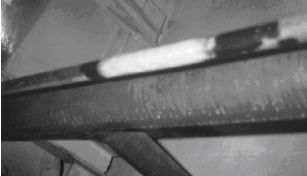
Рисунок 9.23 – Трубопровід конденсату, утвореного з пари під тиском P=1,0 МПа, з намотаним бандажем (12 листопада 2007р.)
