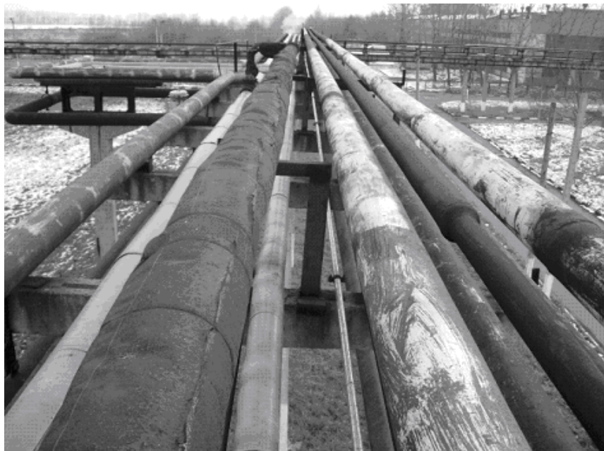
Рисунок 9.19 – Естакада трубопроводів, де проводились випробовування експериментально-дослідних зразків бандажів з полімерно-композитних матеріалів
