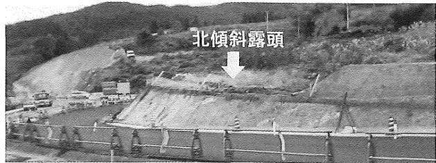
図11 露頭の南側の小規模な切り取り面(位置は図1の×印)でみられる北傾斜の蔵王温泉変質崩壊堆積物
