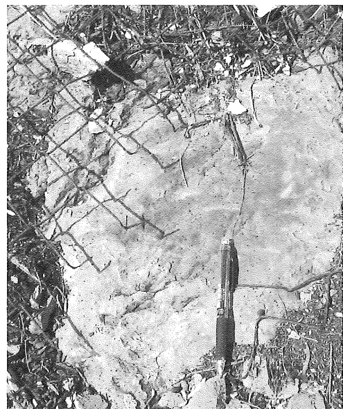
図12 黄鉄鉱を含有する黒色泥岩への法面保護(種子吹きつけ)工における硫酸イオンの関与事例(河北町) 黒色泥岩の層理に沿って植物は枯れ、有機泥が侵食され、金網が溶蝕して裸地化が進行している
