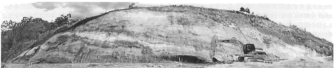
図2 切り取り法面全景 右(北)側に背斜軸をもち, 半固結の色彩豊かな地層
