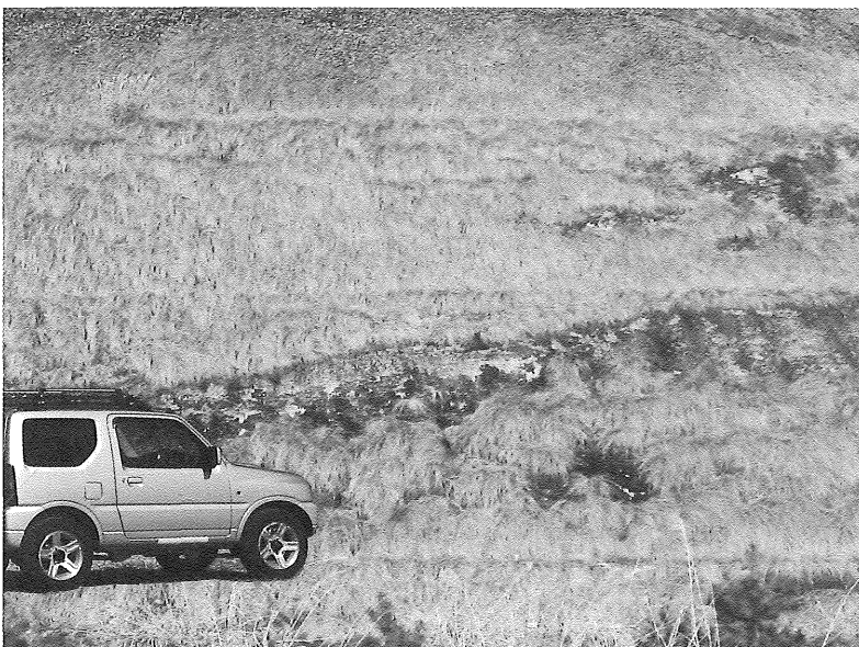
図12 黄鉄鉱を含有する黒色泥岩への法面保護(種子吹きつけ)工における硫酸イオンの関与事例(河北町) 黒色泥岩の層理に沿って植物は枯れ、有機泥が侵食され、金網が溶蝕して裸地化が進行している
