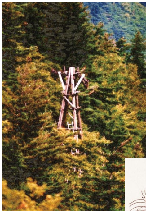
【写真7】 索道の支柱（木造）
