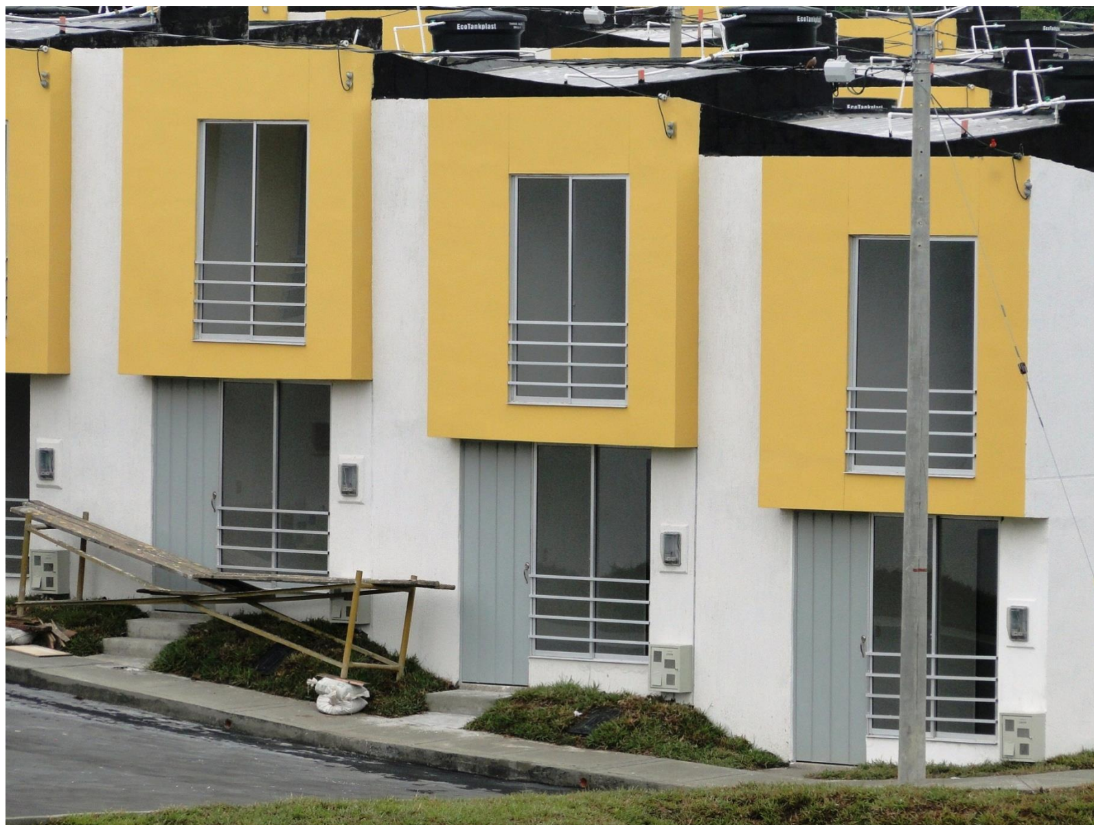
IMAGEN 26. Viviendas de Interés Prioritario Ciudadela Comfenalco. 4.5m de frente por 7,8m de fondo para un área de lote de 35m 2
