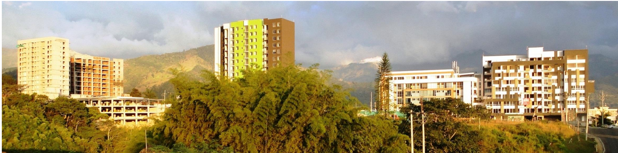
IMAGEN 4. Panorámica de proyectos de densidades altas construidos en el sector de la Carrera 19 al norte de la ciudad que han utilizado la máxima edificabilidad otorgada por el POT 2009
