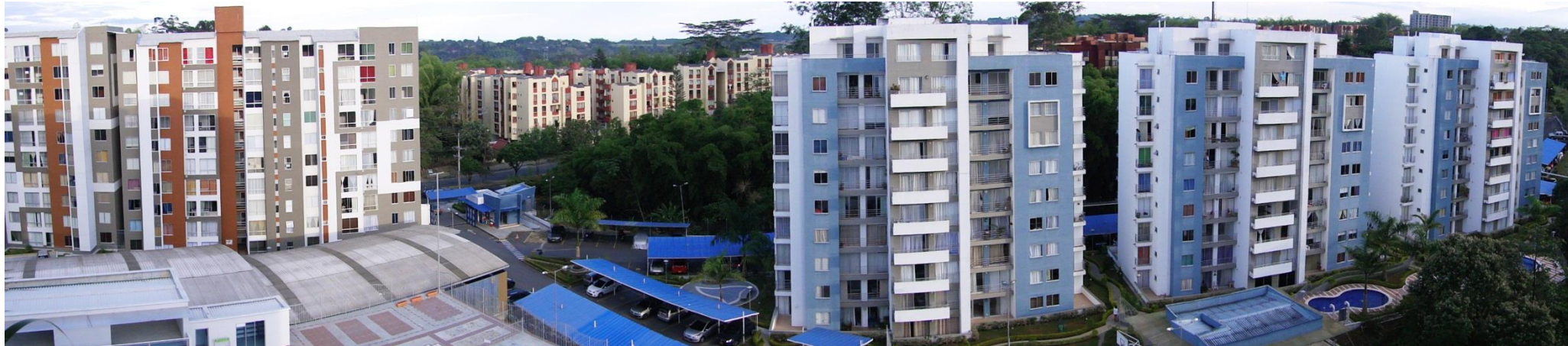
IMAGEN 5. Panorámica de proyectos posteriores al POT 2009 que han utilizado la máxima edificabilidad (primer y segundo plano) frente a proyectos previos al POT (Tercer plano al fondo) que tenían edificabilidad máxima de cinco pisos.
