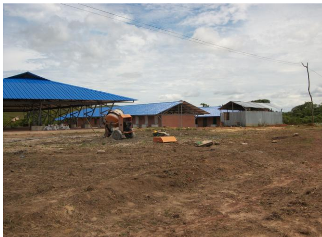
Construcción del colegio Olaya
