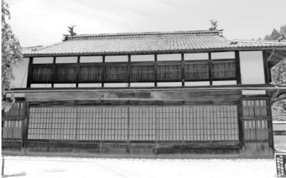
写真 3-1 旧座光寺麻績学校校舎
