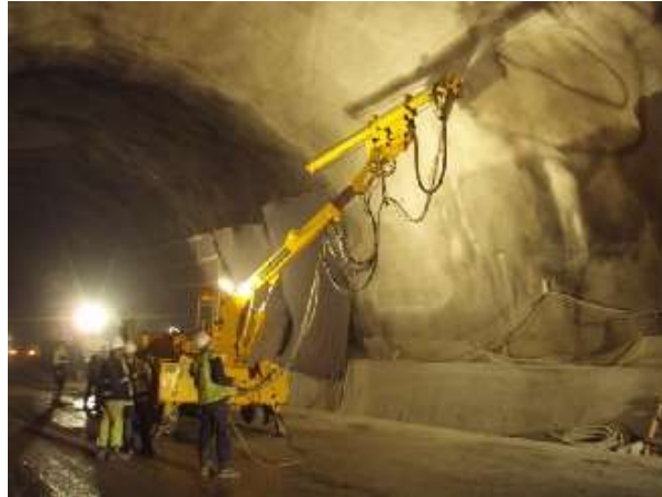
Figura 4.9.-Gunitado mediante robot mecánico
