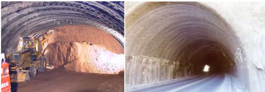
Figura 3.2.- A la izquierda una imagen de la construcción de un túnel en suelo y a la derecha otra de la construcción de un túnel en roca
