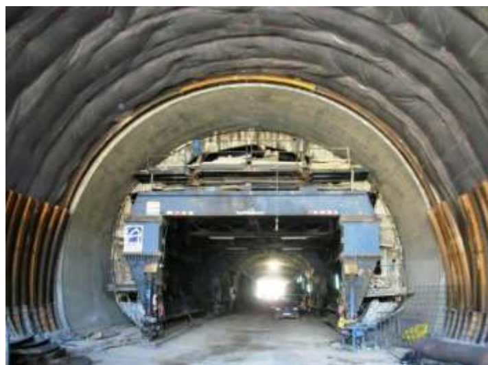
Figura 4.12.-Revestimiento de hormigón bombeado con carro de encofrado
