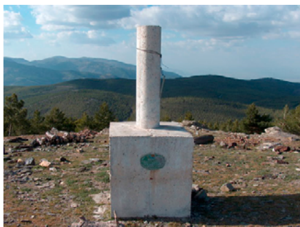
Figura 17. Vértice Geodésico perteneciente a un marco de referencia.
