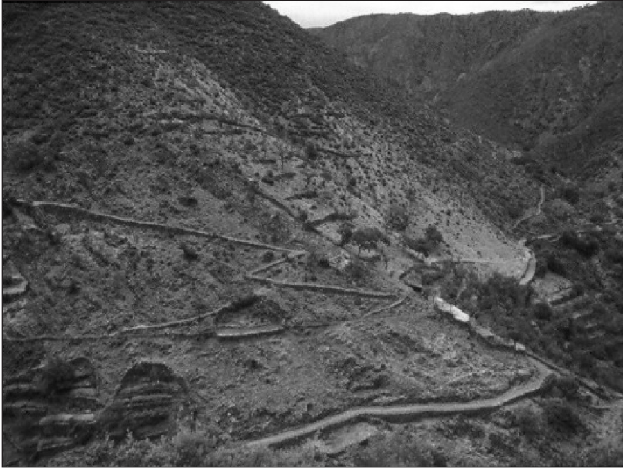
Figura 4. Entramado de caminos empedrados y paredes de abancalamiento y cerramiento de fincas en el curso alto del río Malvellido, junto a El Gasco. Autor: F. Pulido.
