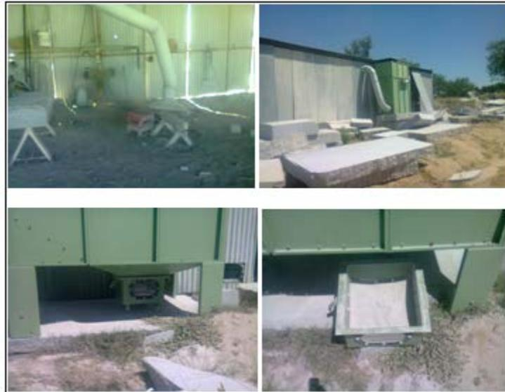
Figura 4.5: instalaciones para la captación de polvo en el taller de labra manual.
