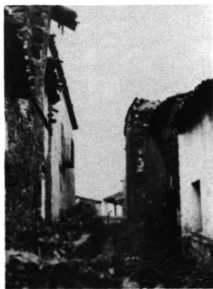
Calle de Granadilla en su situación actual.
