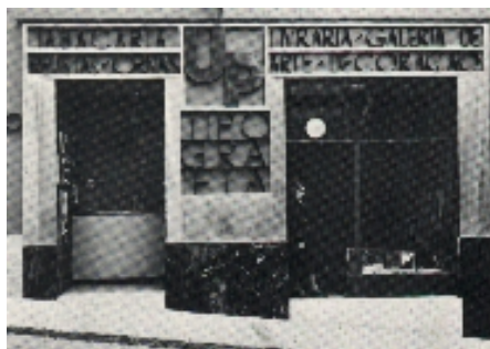
116. Galería UP. Fachada de Jorge Segurado
