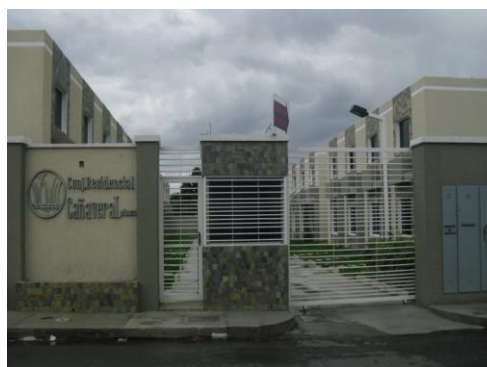
Fotografía 04: Vista de Conjunto Residencial “Cañaverál” (Viviendas de Interés Comercial), ubicada en la Urb. Marco Perdomo, El Tocuyo - Estado Lara
