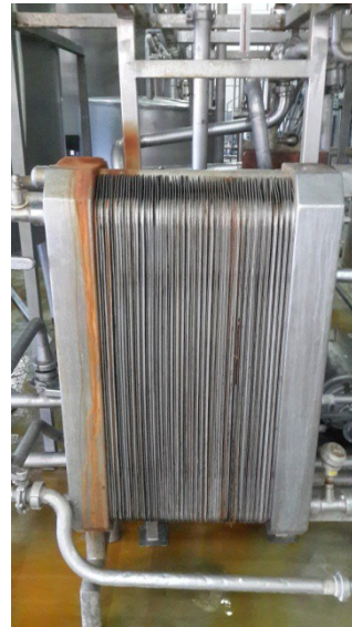
Figura 10: Intercambiador de calor de placas
