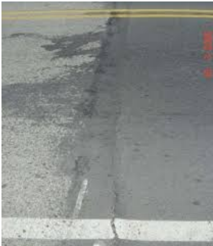
Imagen N° 4 - Fisura transversal en junta de construcción (FCT, Unidad de medida: m 2 -carril)
