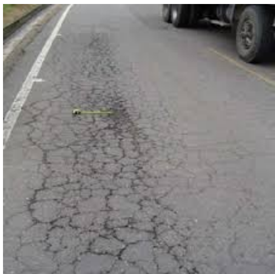
Imagen N° 9 - Piel de cocodrilo (PC, Unidad de medida: m 2 , Penalidad: m 2 -carril)
