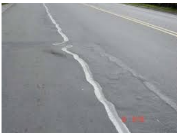
Imagen N° 11 - Ondulación (OND, unidad de medida: Hm)
