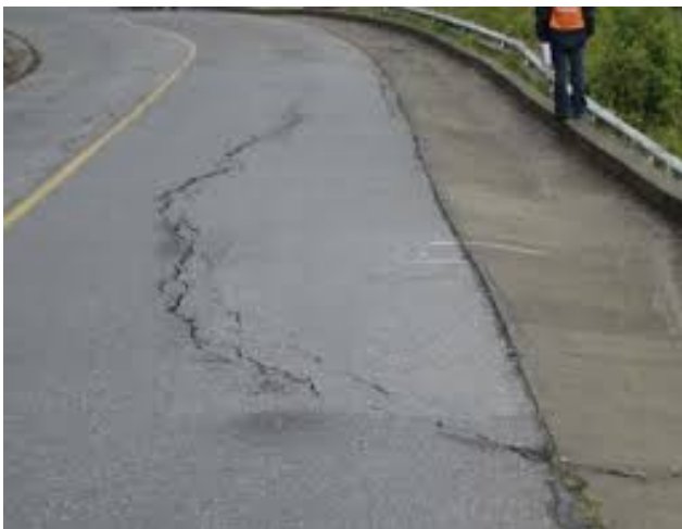
Imagen N° 6 - Fisura en medialuna (FML, Unidad de medida: m2, Penalidad: m2-carril)
