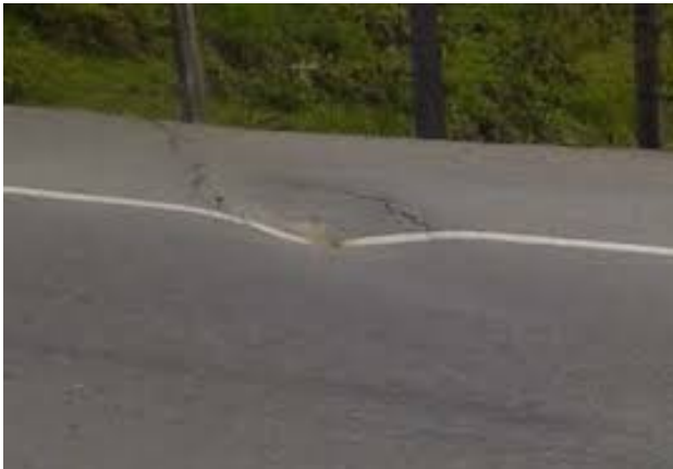
Imagen N° 13 - Hundimiento (HUN, Unidad de medida: Hm)
