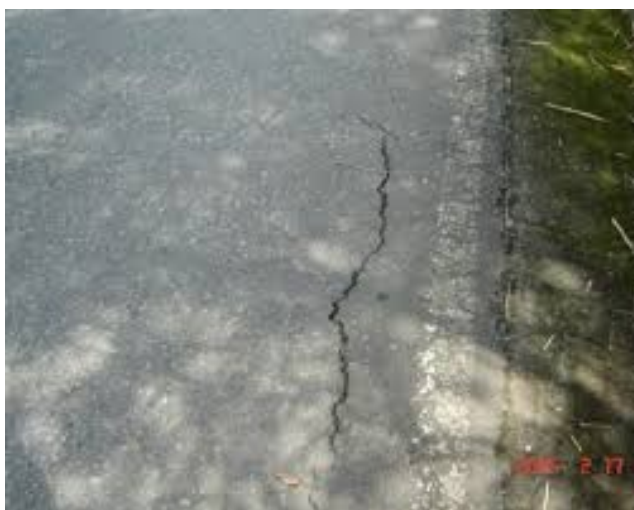
Imagen Nº 7 - Fisuras de borde (FBD, Unidad de medida: m2 carril)
