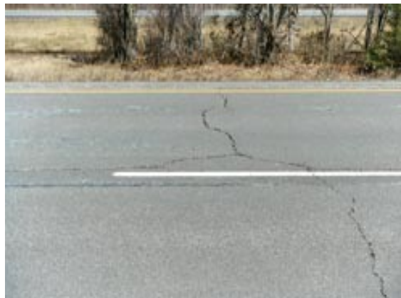
Imagen N° 2 - Fisura transversal (FL, unidad de medida: m, Penalidad: m2-carril)
