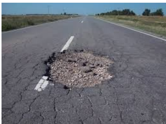
Imagen N° 15 - Descascaramiento (DC, Unidad de medida: m2)
