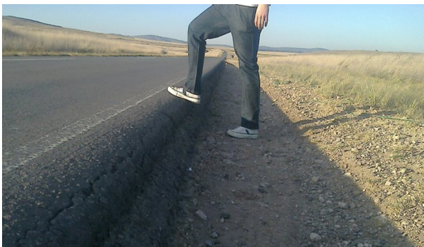
Imagen N° 20 - Corrimiento vertical de la banquina o ahullamiento (CV, Unidad de medida: m)
