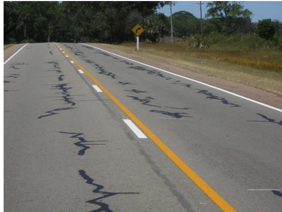
Imagen N° 1 - Fisura longitudinal (FL, unidad de medida: m, Penalidad: m2-carril)
