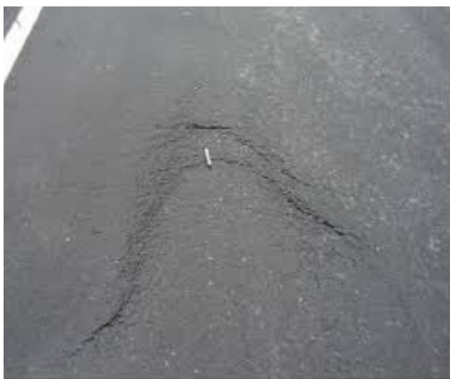
Imagen N° 10 - Fisuración por deslizamiento de capas (FDC, Unidad de medida: m 2 , Penalidad: m 2 -carril)
