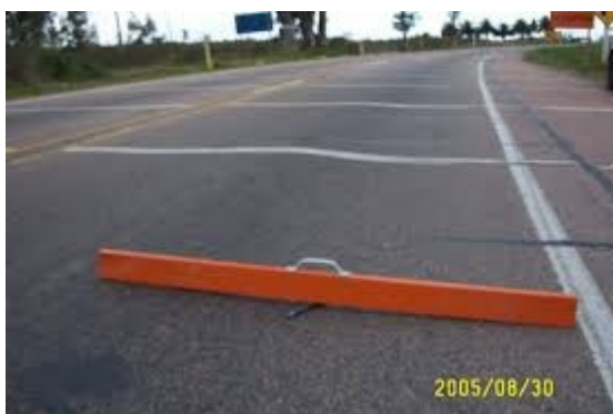
Imagen N° 14 - Ahuellamiento (AHU, Unidad de medida: m 2 , Penalidad: Hm-carril)
