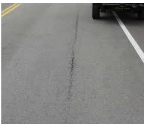
Imagen N° 3 - Fisura longitudinal en juntas de construcción (FCL, Unidad de medida: m 2 , penalidades: m 2 -carril)
