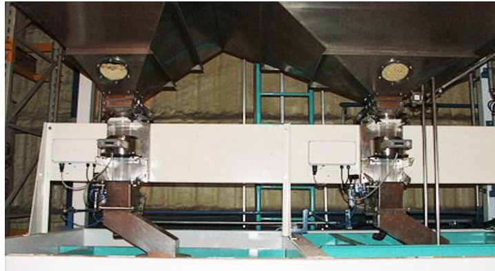
Figura 5.6 Operación de Detección de Metales Inspección (tomado de http://www.gastaldihnos.com.ar/producto-proceso-mani.html )
