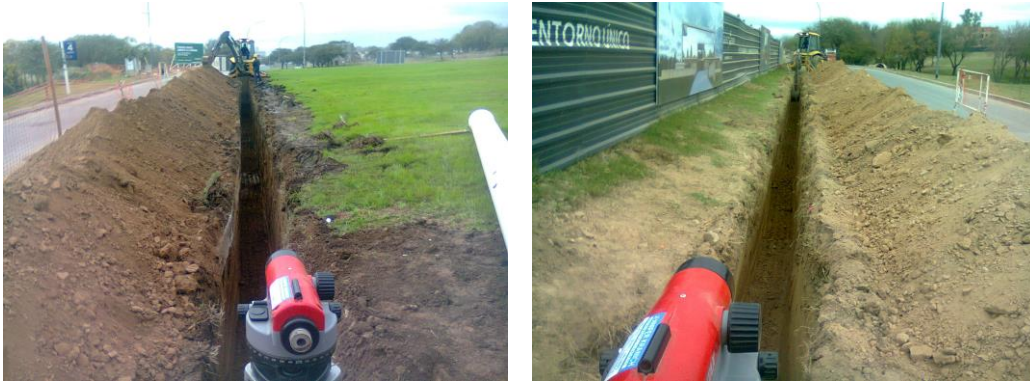
Figura 3.96: Excavación de zanja en suelos estables.
