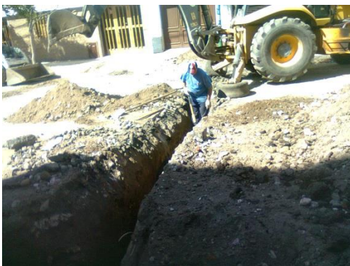
Figura 3.58: Excavación para servicios “largos”.
