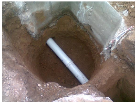
Figura 3.94: Boca de registro profundizada, con la cañería colocada anteriormente.
