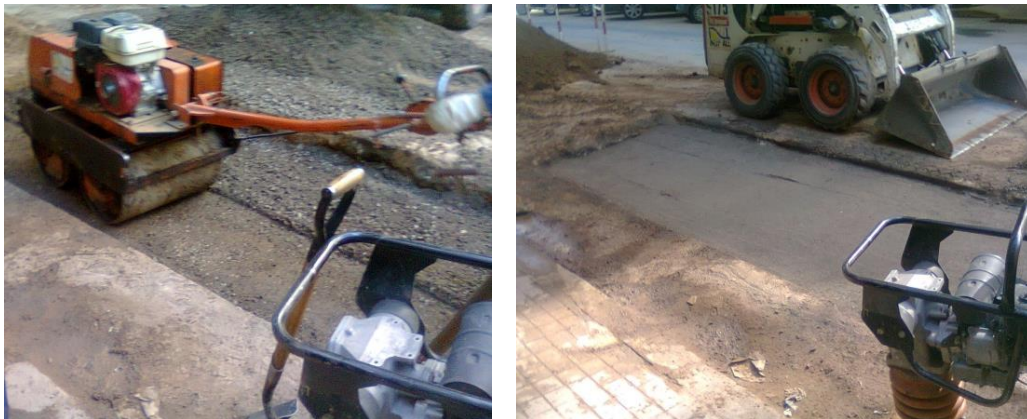
Figura 3.40: Rolo compactador y subbase compactada
