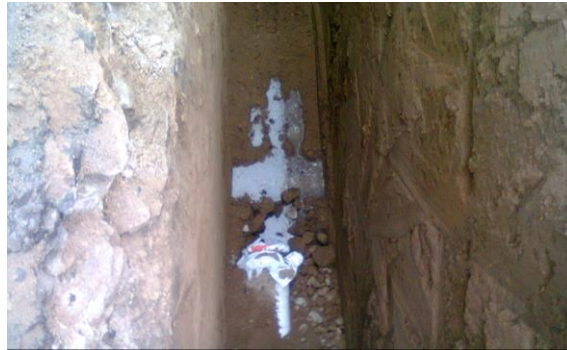
Figura 3.83: Reflujo luego de la pronta rehabilitación del servicio.
