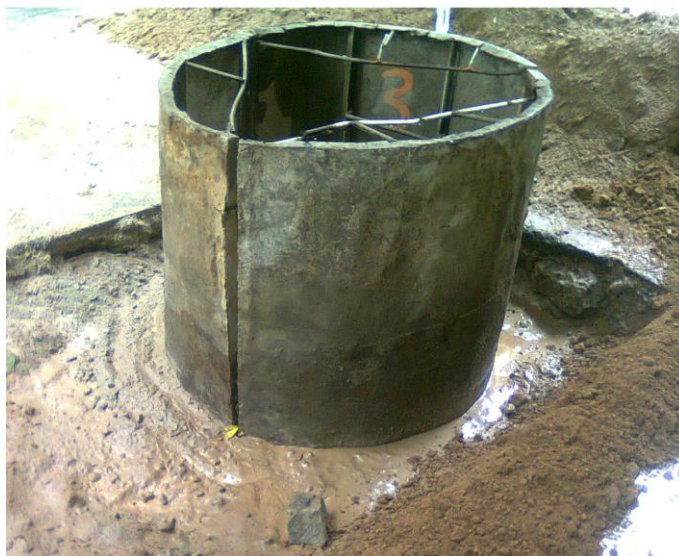
Figura 3.10: Boca de registro hormigonada con su encofrado circular interno
