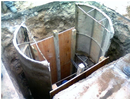
Figura 3.76: Encofrado compuesto para geometría ovalada.
