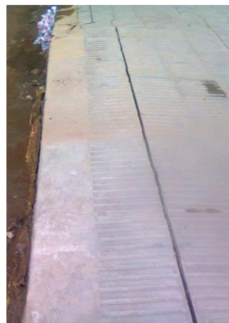
Figura 3.5: Veredas agrietadas por socavamientos.
