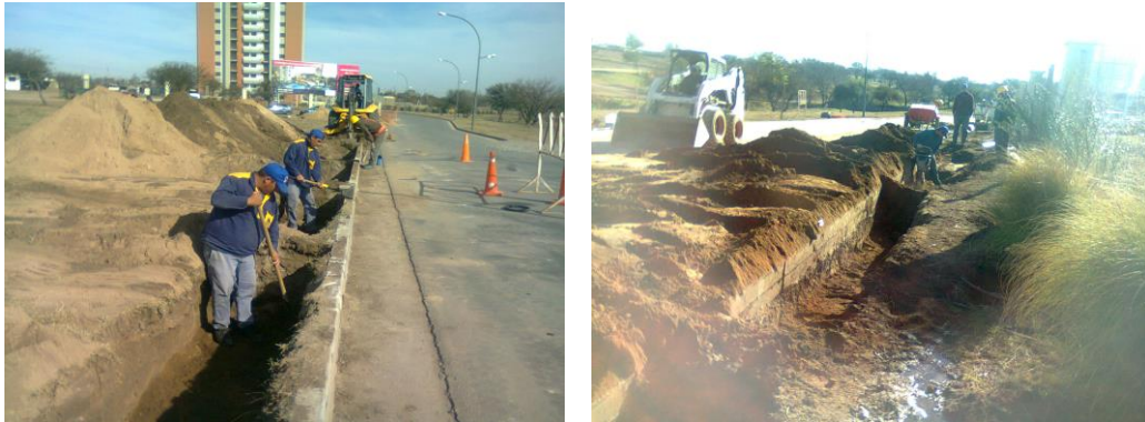
Figura 3.108: Tareas de tapado y compactación de las zanjas.
