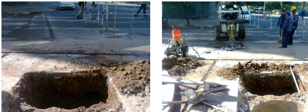
Figura 3.26: Inicio de tareas en Cruce sobre calle Balcarce
