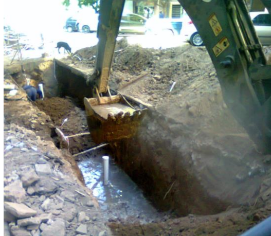
Figura 3.32: Extracción del líquido cloacal durante el reemplazo del servicio.
