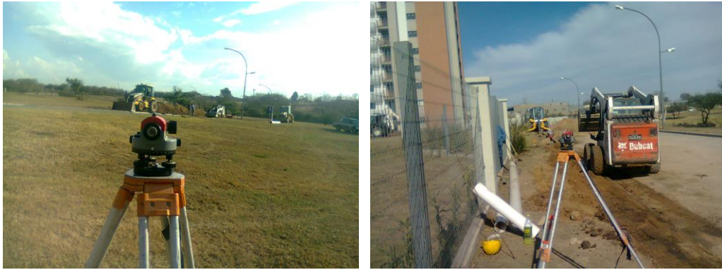
Figura 3.101: Entorno de trabajo durante la tarea de nivelación.
