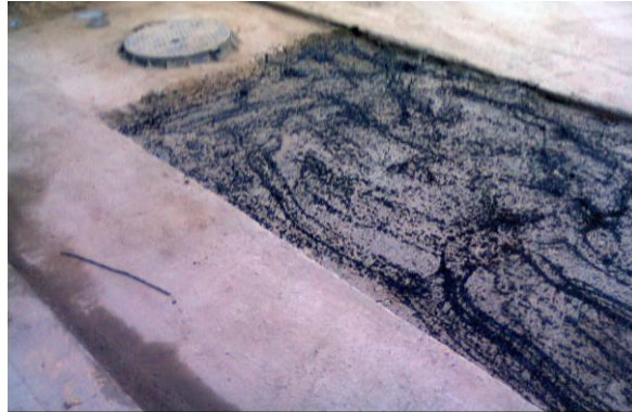
Figura 3.42: Riego de imprimación con emulsión asfáltica.
