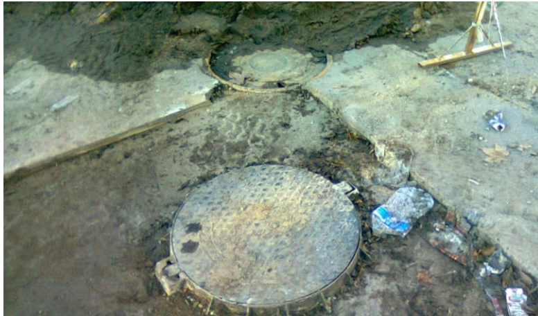
Figura 3.53: BR1 (nueva) y BR existente, ejecutadas a la par.
