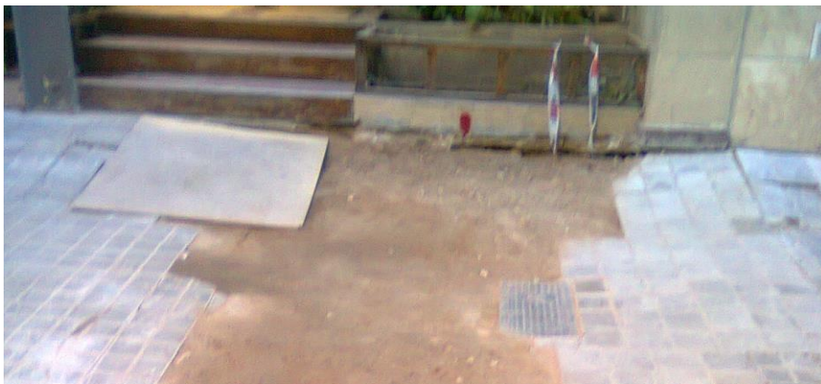
Edificio San Lorenzo N°567
