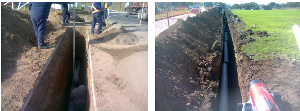
Figura 3.102: Nivelación del tramo completo en suelo estable.
