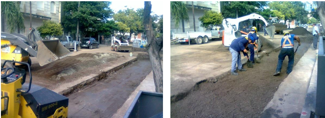
Figura 3.64: Mezclado de materiales y esparcimiento para subbase compactada
