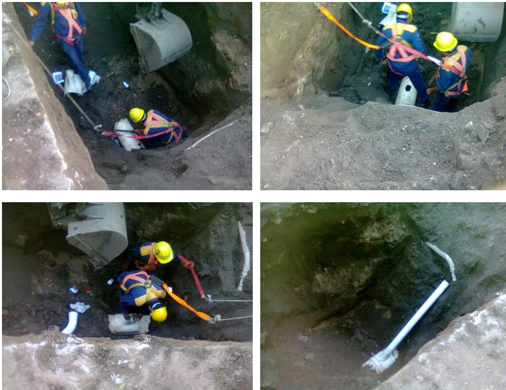
Figura 3.61: Etapas de colocación del Ramal Postizo.
