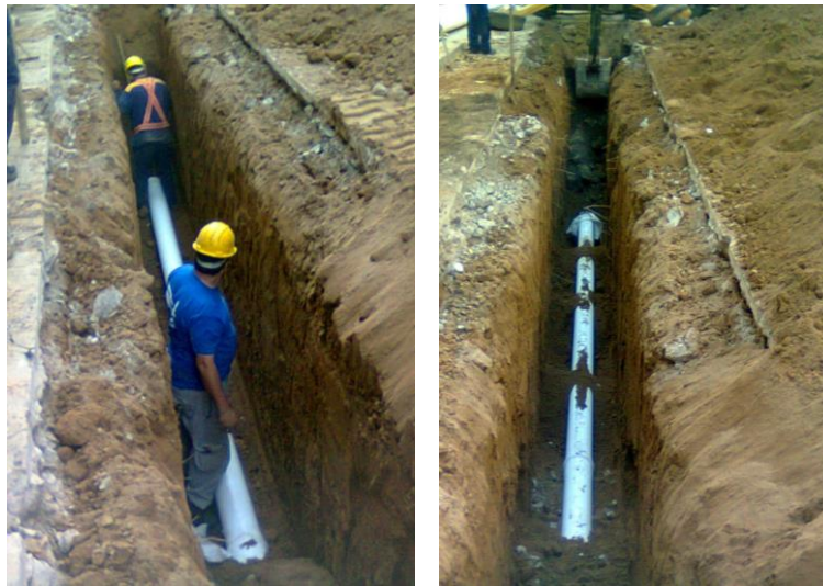
Figura 3.21: Colocación de la cañería en el Tramo BR2-BR3.
