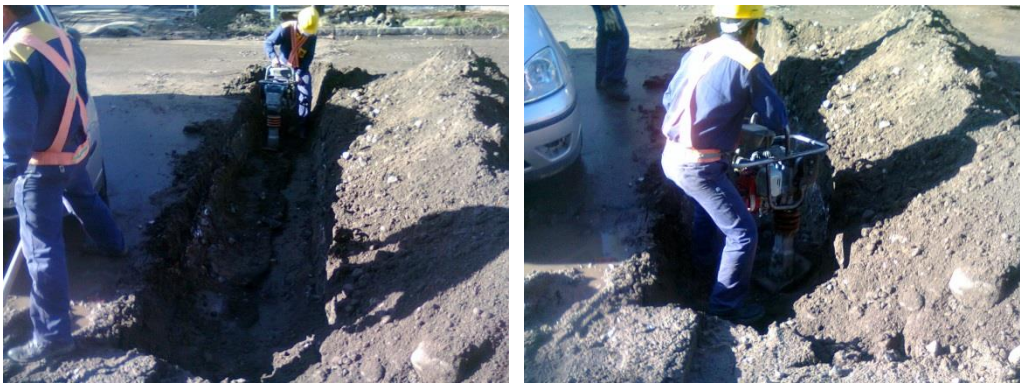
Figura 3.63: Compactación de cruces domiciliarios.
