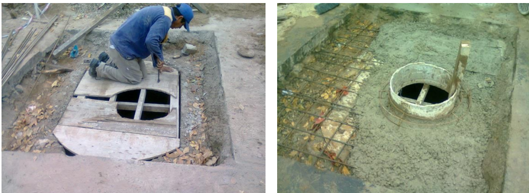
Figura 3.78: Encofrado, armadura y hormigonado de losa rectangular
