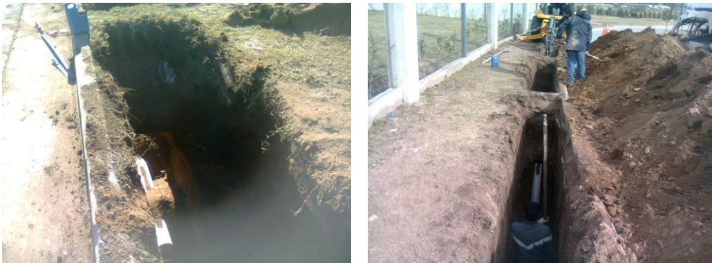
Figura 3.100: Excavación intercalada por túneles para evitar desmoronamientos.
