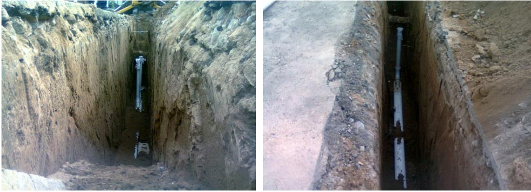
Figura 3.87: Cañería principal colocada y nivelada.
