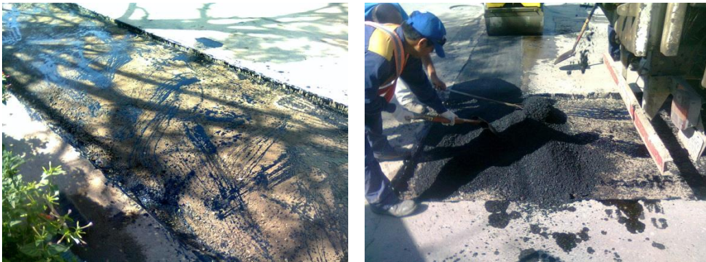
Figura 3.66: Riego de imprimación – Esparcido y emparejado de la mezcla asfáltica
