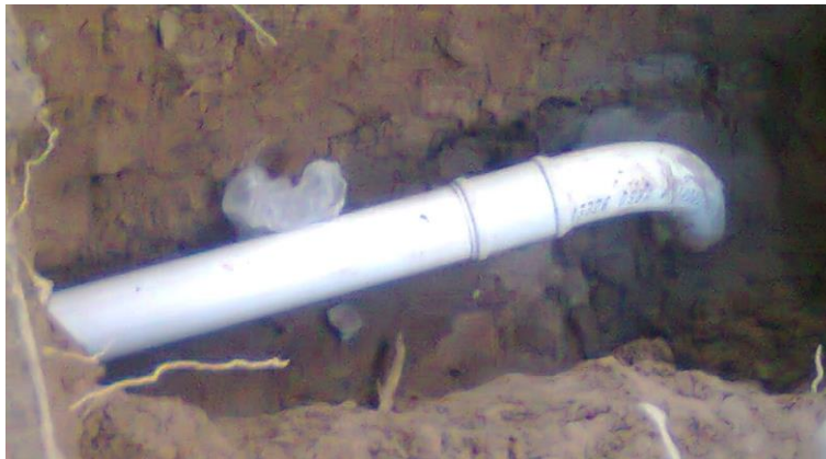
Figura 3.35: Acometida servicio domiciliario - Colectora
