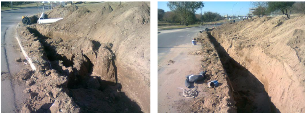
Figura 3.97: Excavación de zanja en suelos de mantos arenosos superficiales.
