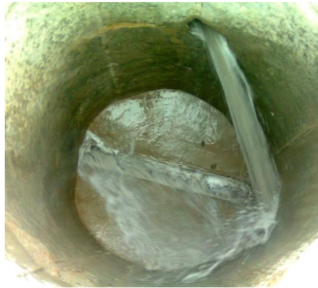
Figura 3.95: Boca de registro profundizada: habilitación del servicio cloacal.
