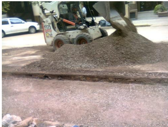
Figura 3.38: Mezclado de estabilizado granular calcáreo 0-20 con cemento.
