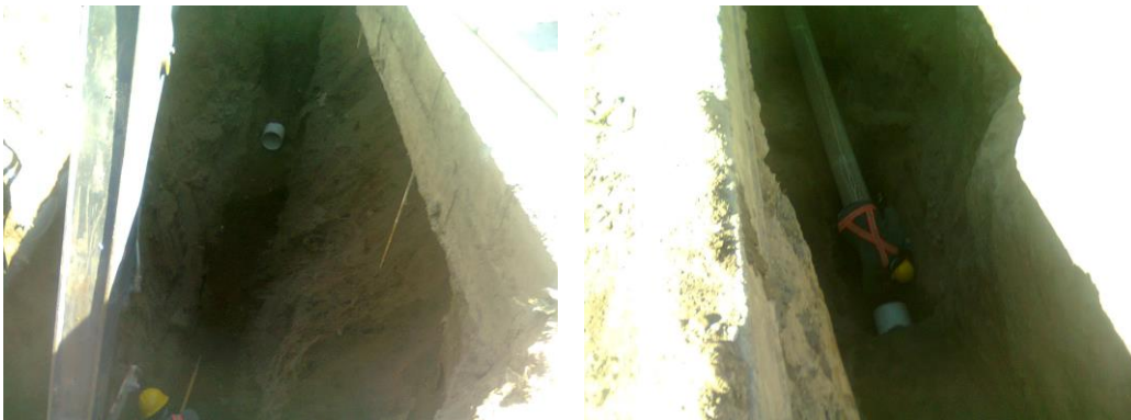
Figura 3.104: Colocación de cañería en sector crítico de suelo arenoso desmoronable
