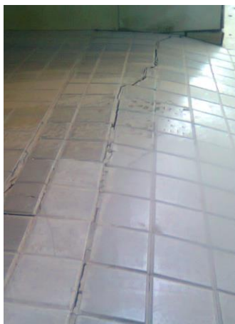
Figura 3.5: Veredas agrietadas por socavamientos.
