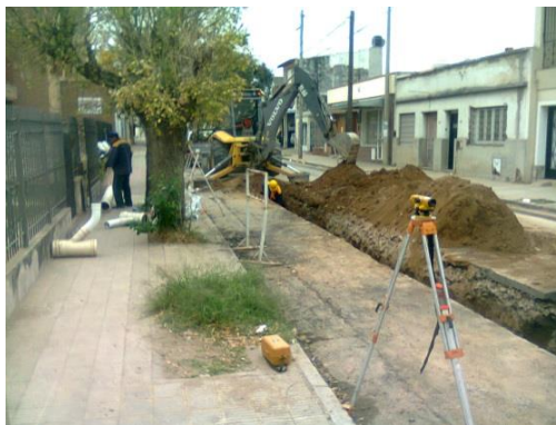
Figura 3.84: Entorno de trabajo en la colocación de la cañería.
