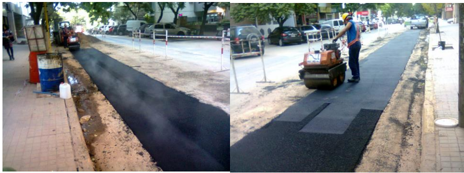
Figura 3.44: Compactado de la Base asfáltica por peso propio y por vibración del rolo.
