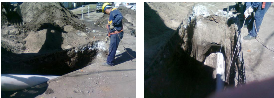
Figura 3.55: Bajada de conductos para su colocación y nivelación.
