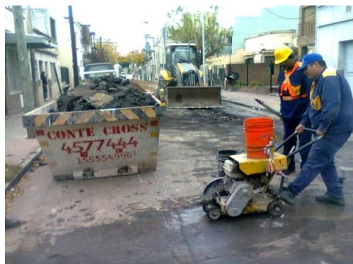
Figura 3.73: Aserrado del pavimento. Acopio de escombros.
