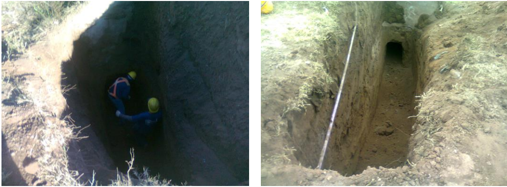
Figura 3.105: Ejecución manual del túnel bajo el Canal Maestro Sur.
