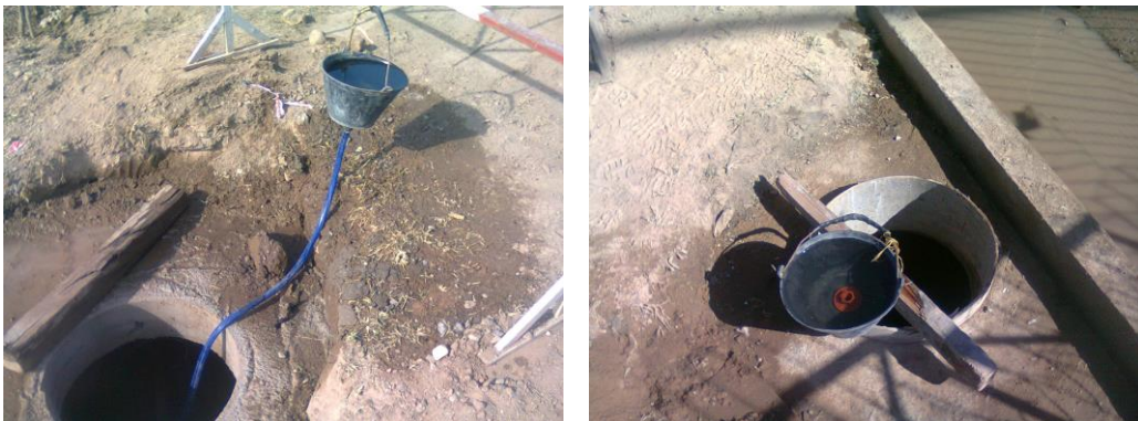
Figura 3.110: Diferentes ubicaciones del balde para garantizar los 2 m.c.a. exigidos.
