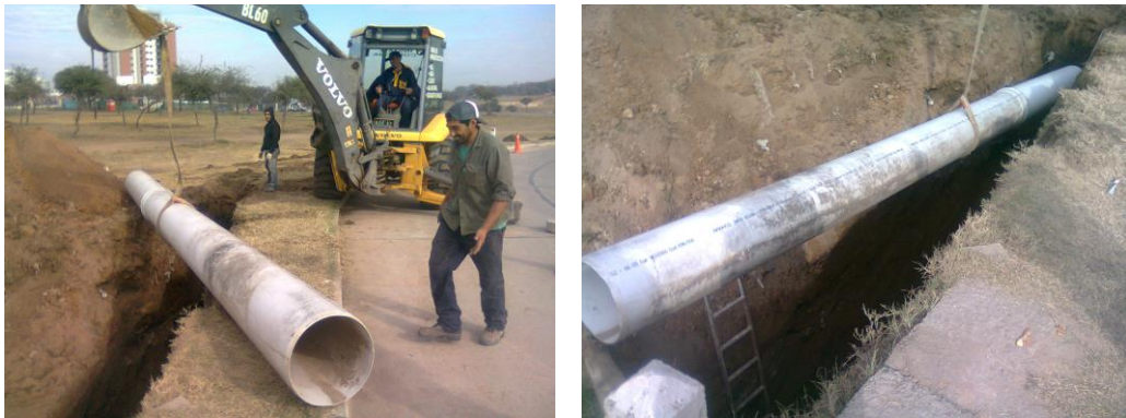
Figura 3.106: Trabajos de descenso del caño camisa.
