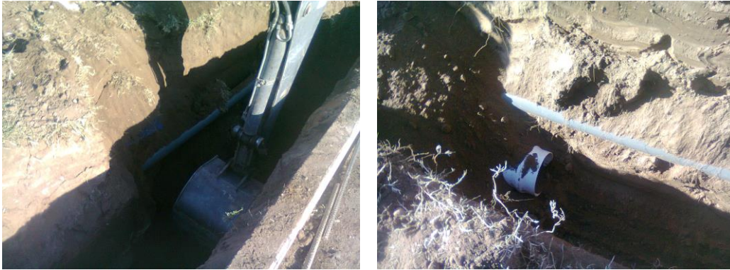
Figura 3.99: Excavación de zanjas en proximidad a la cañería de agua.
