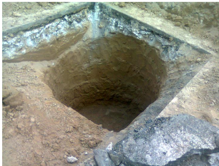
Figura 3.9: Excavación finalizada para Boca de Registro
