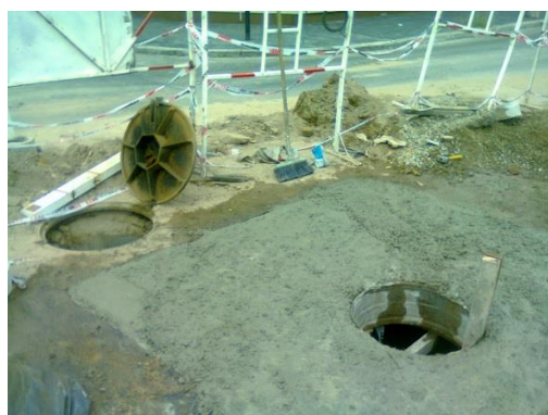
Figura 3.79: Adyacencia de boca de registro nuevo con existente.
