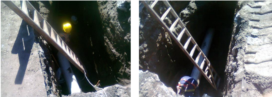
Figura 3.56: Tareas de colocación y nivelación de cañerías.
