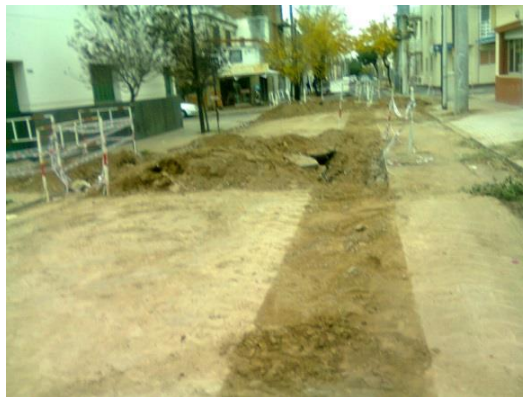
Figura 3.75: Estado de la obra luego del aserrado y rotura.
