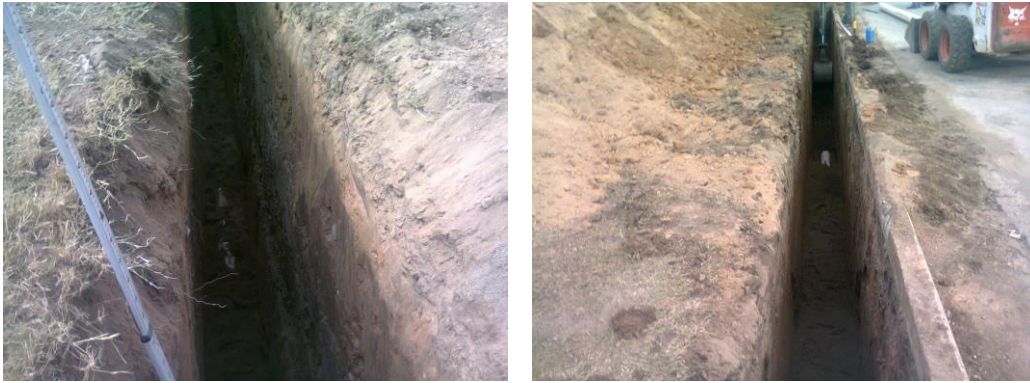
Figura 3.103: Cañería colocada con capa de arena 0-6 para protección.
