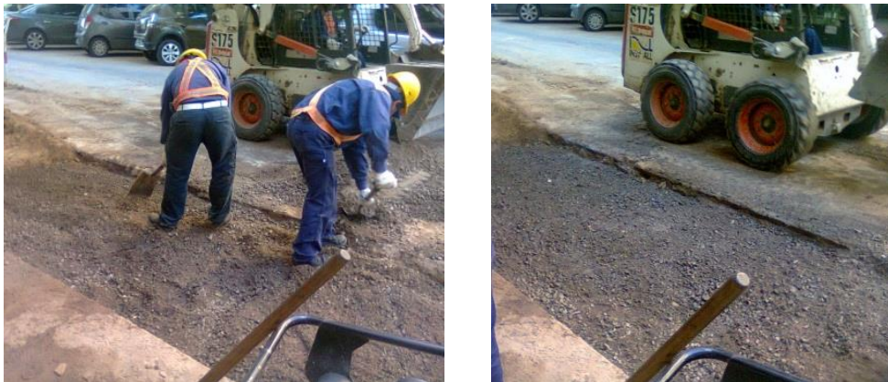
Figura 3.39: Conformado de capa de mezcla granular previo a la compactación.
