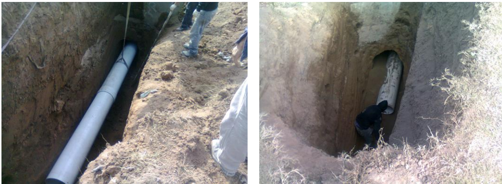
Figura 3.107: Colocación y fijación del caño camisa dentro del túnel.
