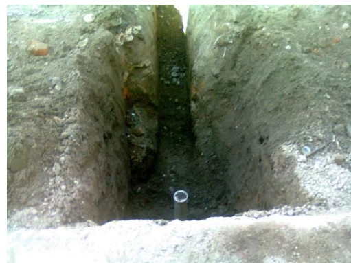
Figura 3.58: Excavación para servicios “largos”.
