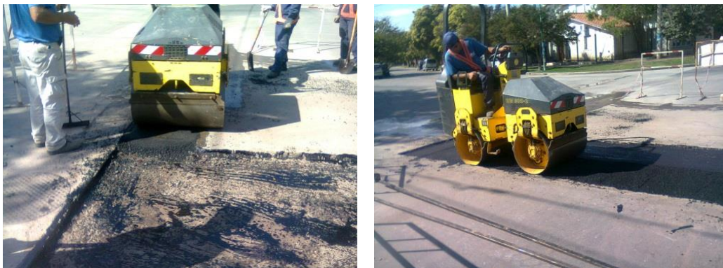
Figura 3.67: Compactado de mezcla asfáltica
