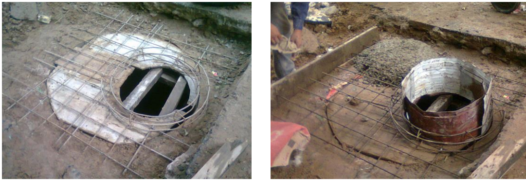
Figura 3.11: Encofrado y armadura de losa.
