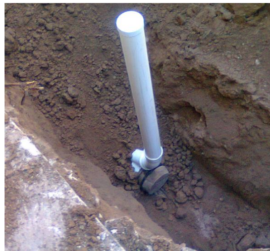
Figura 3.20: Conexión de ramales y suplemento vertical para servicio domiciliario.
