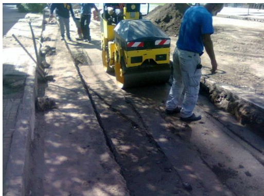
Figura 3.65: Compactado de subbase granular estabilizada.
