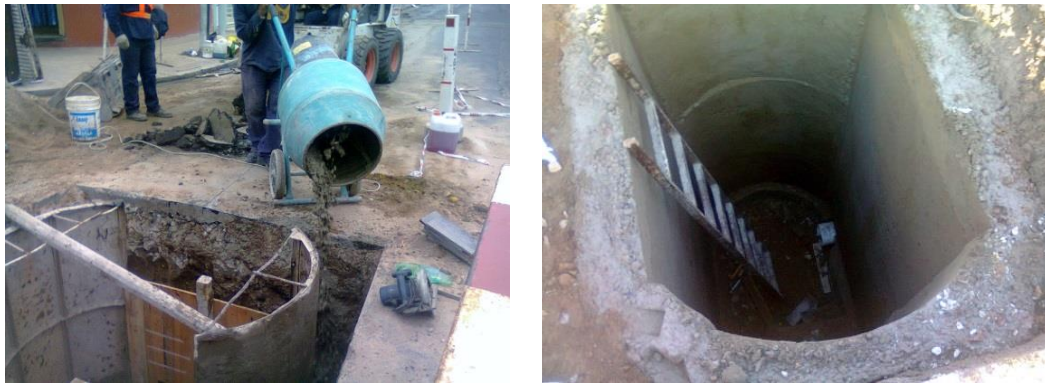
Figura 3.77: Hormigonado de boca de registro de forma oval.
