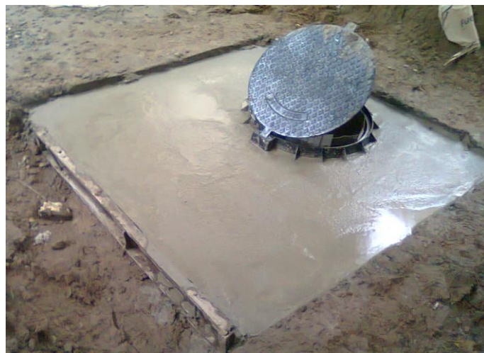
Figura 3.12: Losa hormigonada. Aro y Tapa de fundición colocados.
