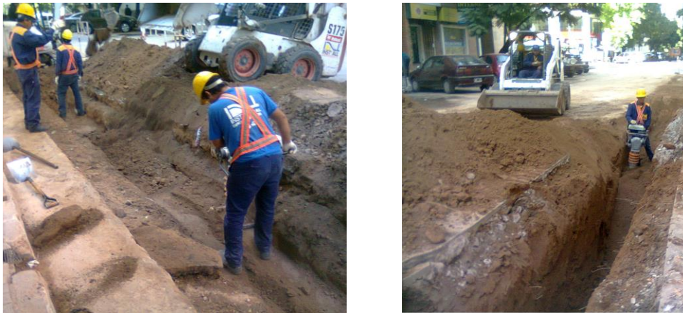
Figura 3.23: Compactación con apoyo del Minicargador Bobcat S175
