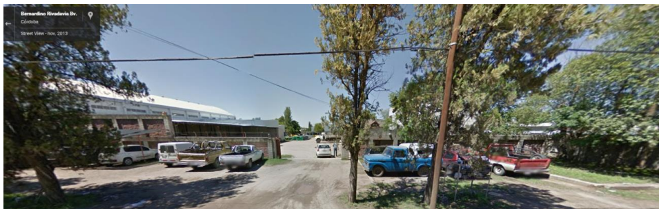
Figura 2.2: Frente de ingreso a INST'ALL SRL.
