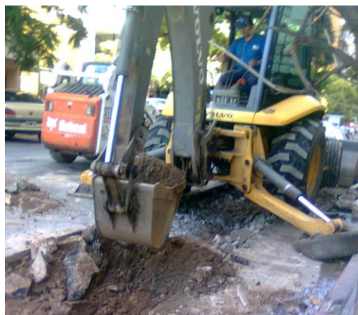
Figura 3.14: Tareas de excavación de zanja para cañería principal.
