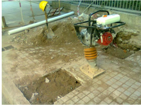
Figura 3.37: Compactado de servicios domiciliarios.
