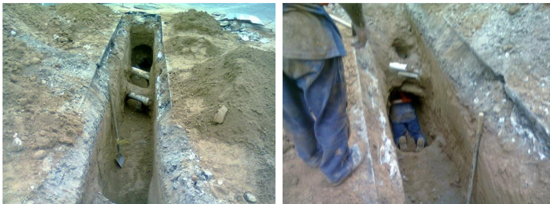
Figura 3.27: Cruce sobre calle Paraná: Excavación mecánica de zanja y túnel a mano.
