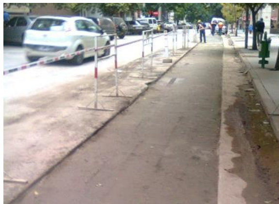
Figura 3.41: Subbase y Base granular compactada
