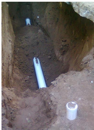
Figura 3.18: Cañería colocada en el tramo BR1-BR2.
