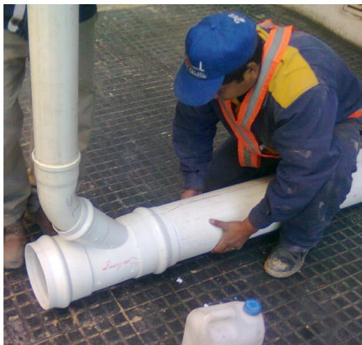
Figura 3.20: Conexión de ramales y suplemento vertical para servicio domiciliario.
