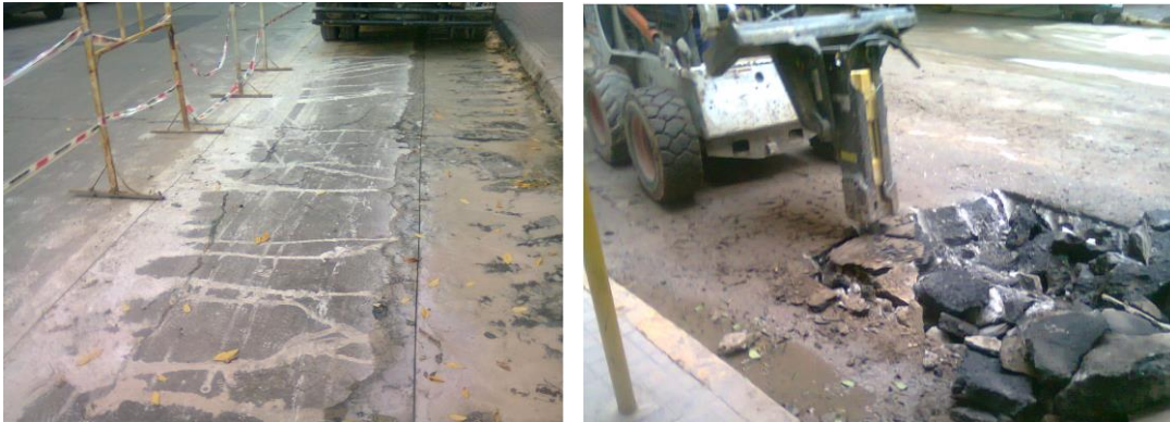
Figura 3.7: Pavimento aserrado y tarea de rotura.
