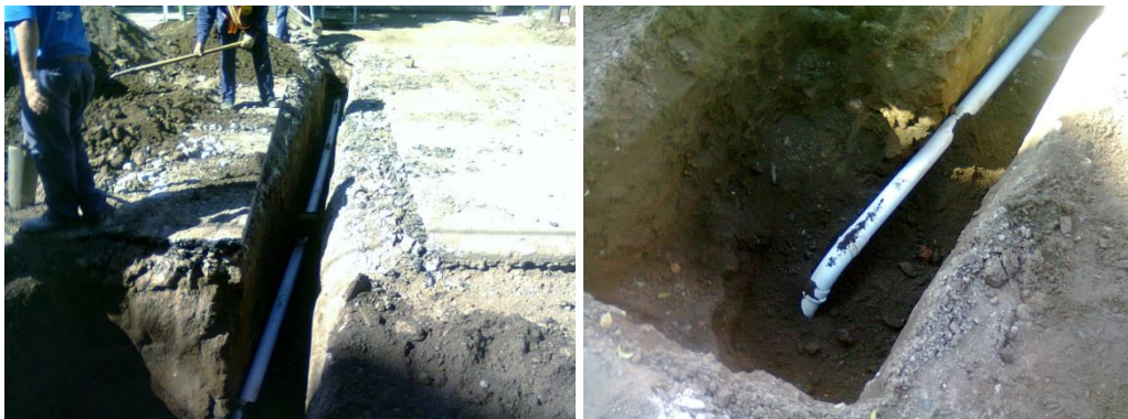
Figura 3.62: Colocación y nivelación de la cañería en el cruce de calzada.
