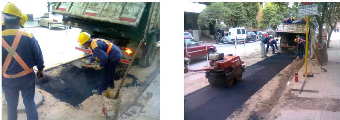
Figura 3.43: Colocado y emparejado de mezcla asfáltica en caliente.
