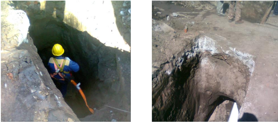
Figura 3.54: Ejecución de un pequeño túnel para evitar desmoronamientos.
