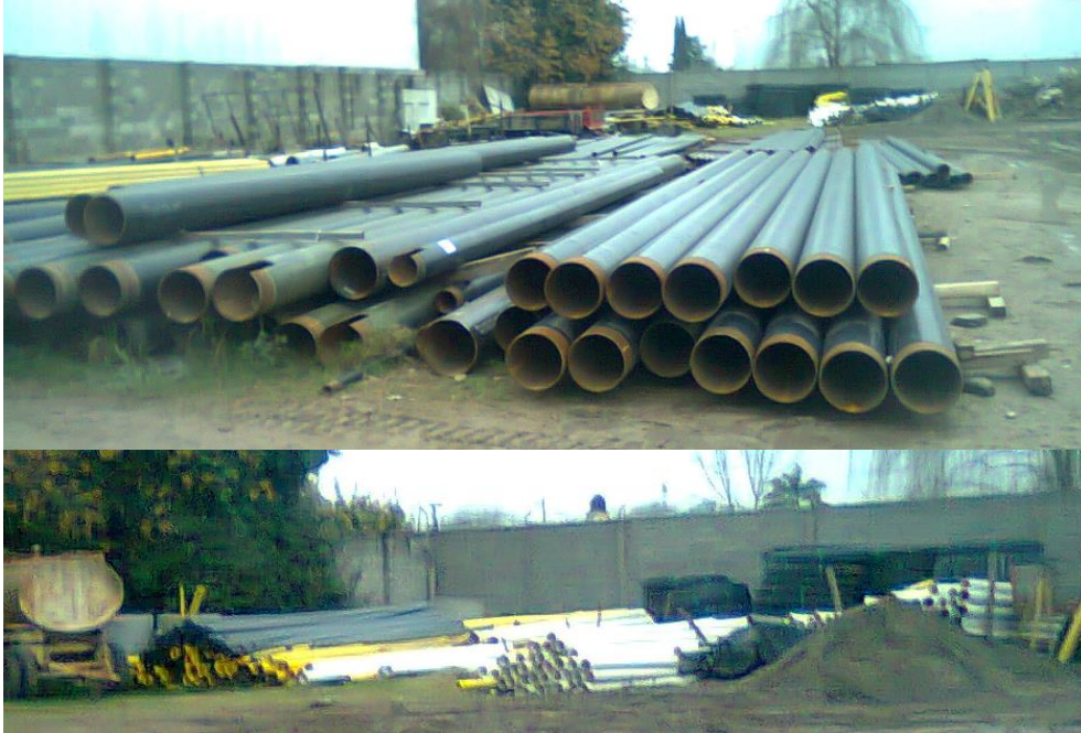
Figura 2.9: Acopio de cañerías al aire libre
