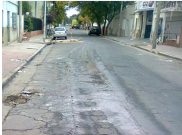
Figura 3.71: Estado de la cuadra previo a los trabajos.
