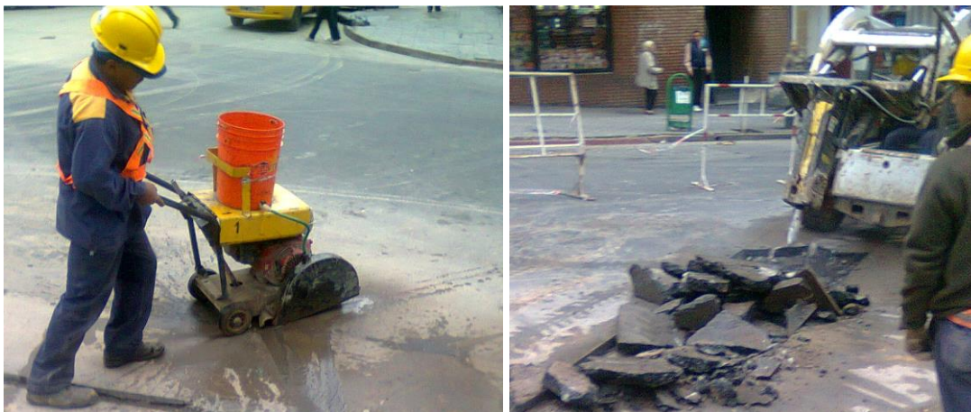
Figura 3.8: Aserrado y rotura de pavimento sobre cruce en calle Paraná.
