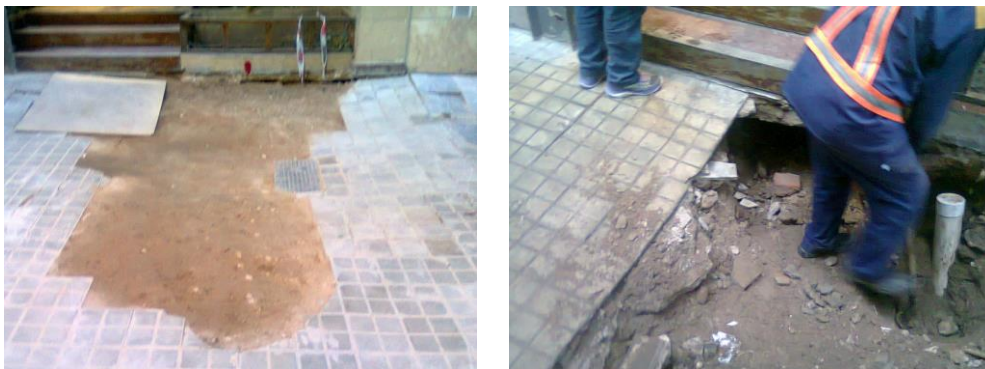
Figura 3.30: Reemplazo de servicios en veredas socavadas.
