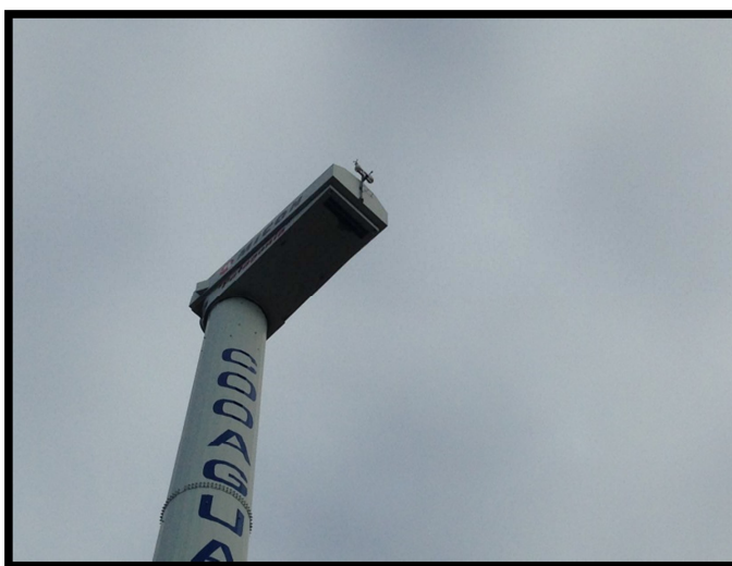
Fotografía 2.6: góndola, anemómetro y veleta
