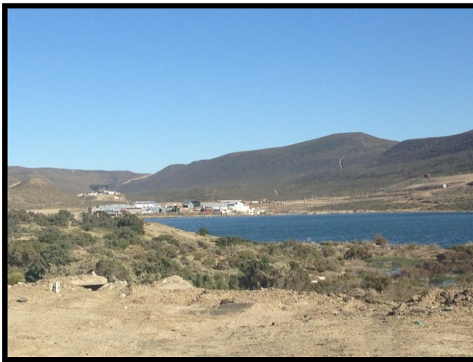
Fotografía 2.1: Vista planta de tratamiento de agua
