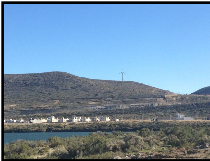
Fotografía 2.2: vista Molino desde la laguna adyacente a la planta de tratamiento de agua
