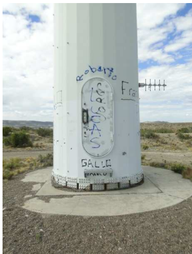
Fotografía 5.1: puerta de acceso a la torre
