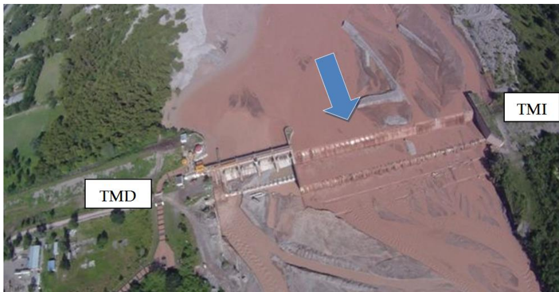
Figura 19: Imagen aérea tomada durante una crecida el día 22 de Enero de 2013. Terraplén Margen Izquierda (TMI) y Terraplén Margen Derecha (TMD)
