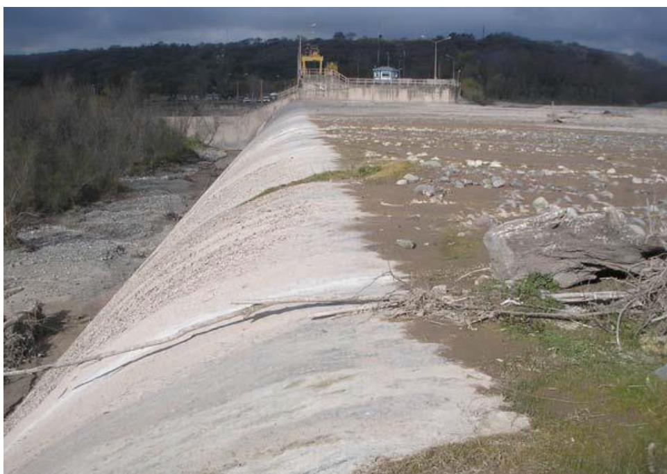
Figura 20: Dique Fijo tarquinado observado desde la margen izquierda. (Halcrow, 2009).
