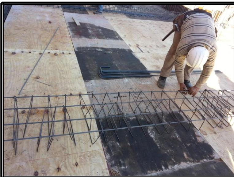
En la fig. 3.32 no llega a apreciarse, pero la persona que lleva la tarea de la colocación de los estribos poseía una tablilla preparada y cortada con la separación que debían contener los mismos, para poder guiarse en el primer atado.
