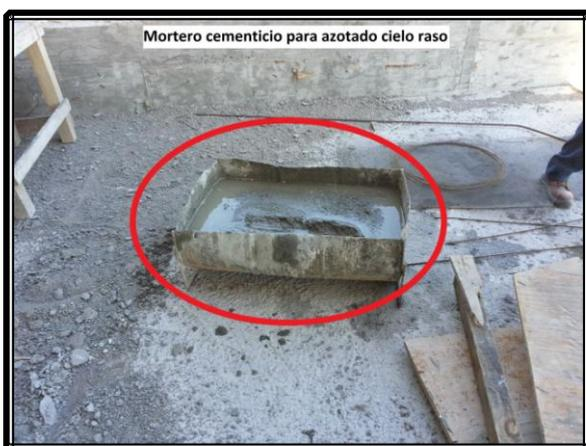
Notamos que el dosaje del azotado al ser de alto tenor cemento acompaña el principio de los revoques en el cual se establece que las capas posteriores a aplicar por encima de la última ejecutada siempre deben poseer una resistencia menor o igual a la anterior, para no estar introduciendo una capa "fuerte" sobre una "débil" ocasionando una mal funcionamiento del conjunto o que pueda llegar a provocar desprendimientos de la capa base débil.
