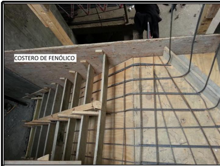
Una vez replanteado los peldaños se materializaron como se muestra en la figura mediante tabloncillos clavados, previo a ello se colocó la armadura inferior en su posición, sujetándose al tablero de fondo mediante atadura con alambre en los lugares donde se colocaron los espaciadores para garantizar el recubrimiento que la misma lleva.
