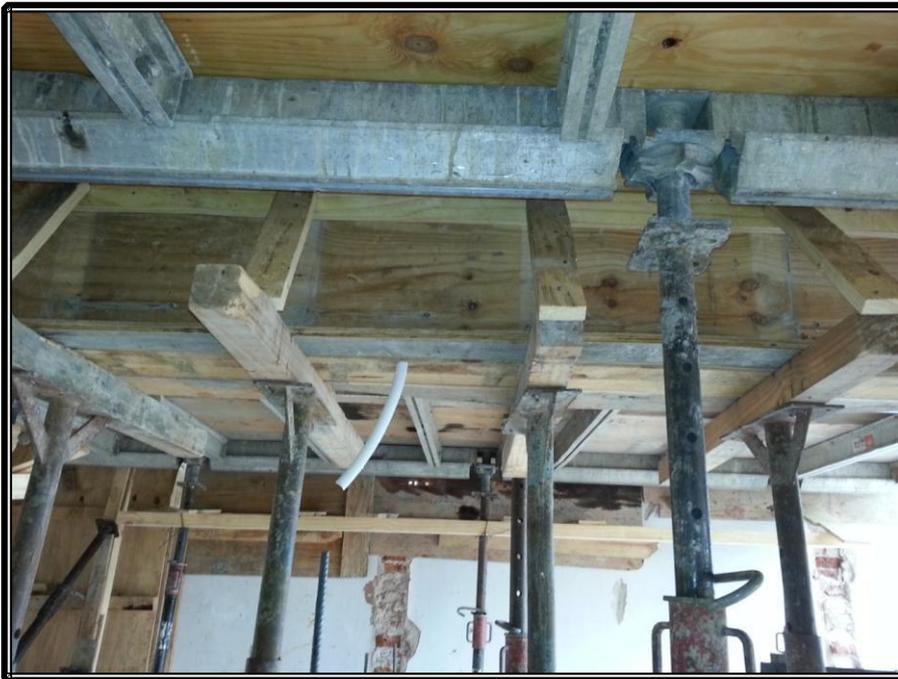
**Fig. 3.16** *Encofrado de viga medianera.*
