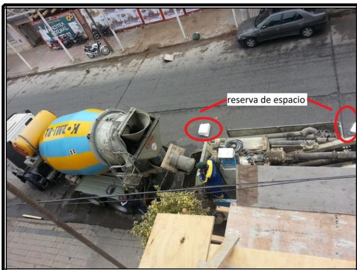
El flujo de hormigón fue controlado en función del pedido del capataz de obra y mediante los operarios de la empresa terciarizada, quienes se intercomunicaban para regular el envío a la manga que se les indicaba como necesidad, con dispositivos de radiofrecuencia (handies). Obsérvese lo mencionado en la fig. 3.37.
