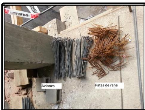
**Fig. 3.31 Paquetes para armados de nervios.**
