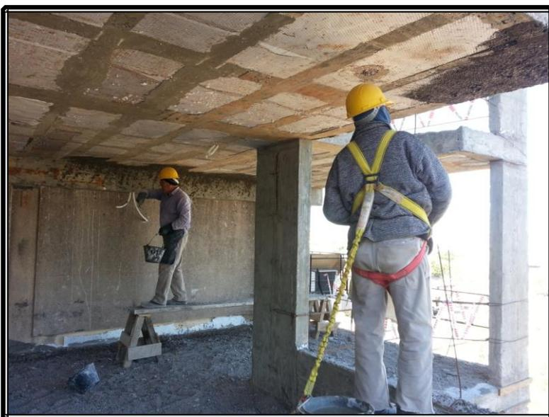
**Fig. 3.67 Detalle de sección recién castigada con el mortero cementicio.**
