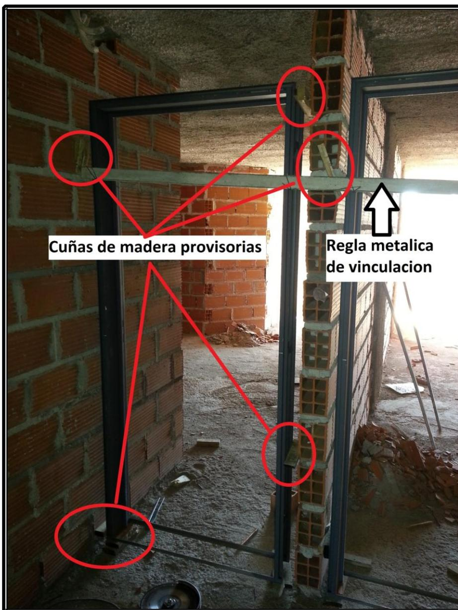
Se muestra en la imagen 3.60 como se propuso utilizar un separador para dar el grosor del revoque con una sección de una barra del mismo espesor. A demás se visualiza el detalle de la utilización de una regla de mayor longitud y un hilo para poder presentar de manera correcta y coincidente en un plano las artistas visibles de los marcos que se ubican sobre un mismo muro, dando mayor prolijidad y calidad de terminación al trabajo.
