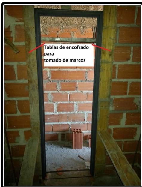
Observamos en la siguiente imagen (fig. 3.62) como un operario realiza la tarea ya aclarada de humedecimiento previa al tomado con mortero y la aplicación de un montante para evitar como se mencionó anteriormente, que el marco se deforme en el proceso de tomado con mortero.
