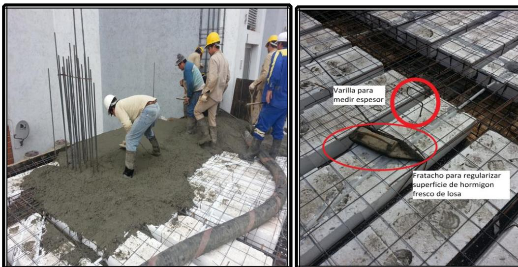
Estos mismos operarios eran a quienes se les indicaba cuando debían ir dejando los aviones colocados en el hormigón fresco para luego tener puntos de amarre y materializar así los futuros durmientes para poder de esta manera sujetar las flechas de los encofrados de las columnas.
