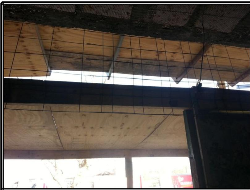
Con respecto a las bandejas móviles, las mismas se ubicaron un piso por debajo del cual se está trabajando como la reglamentación así lo indica, con una estructura metálica similar a las anteriores (fijas) para dar soporte y un enrejado de malla cima cubierto de media sombra como cerramiento.
