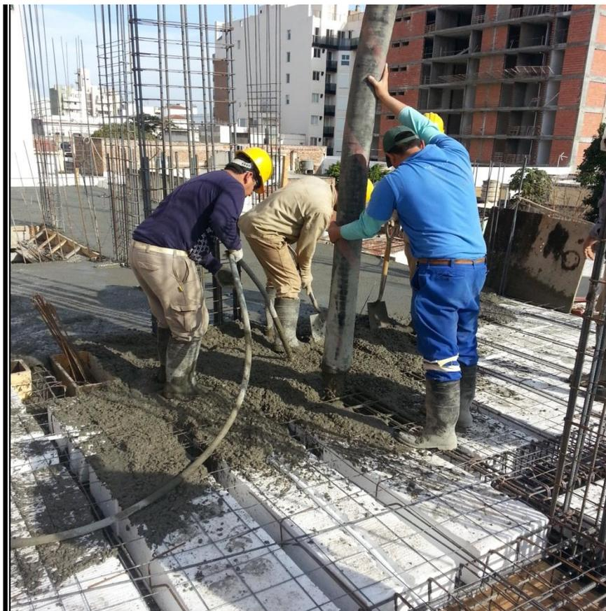
Luego se procedía a realizar un fratasado para nivelar la superficie de la losa por dos operarios, quienes constaban con un elemento ya otorgado y visado hecho de una varilla de hierro de 8 mm doblado a medida para controlar el correcto espesor en todas sus zonas. Fig. 3.39
