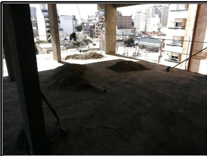
**Fig. 3.69 Preparación del piso para el azotado del cielo raso.**
