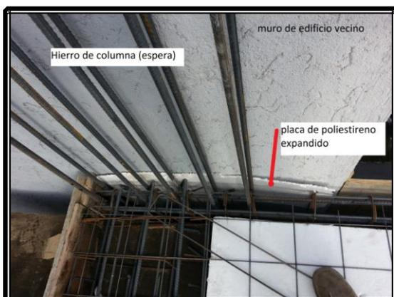
**Fig. 3.8 Calado de columnas medianeras.**
