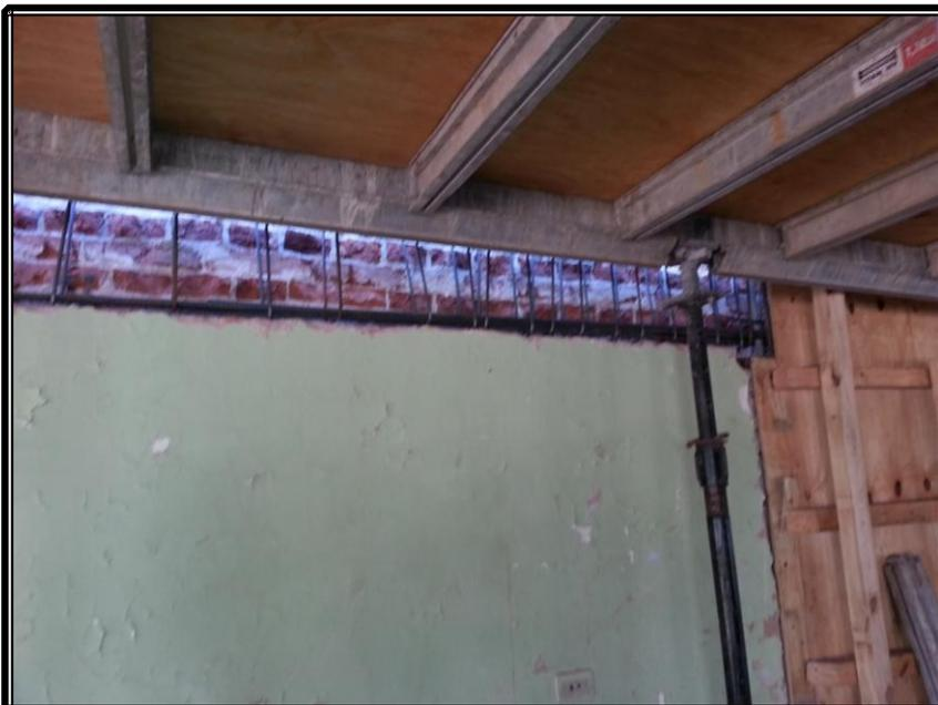
**Fig. 3.18 Encofrado viga medianera.**
