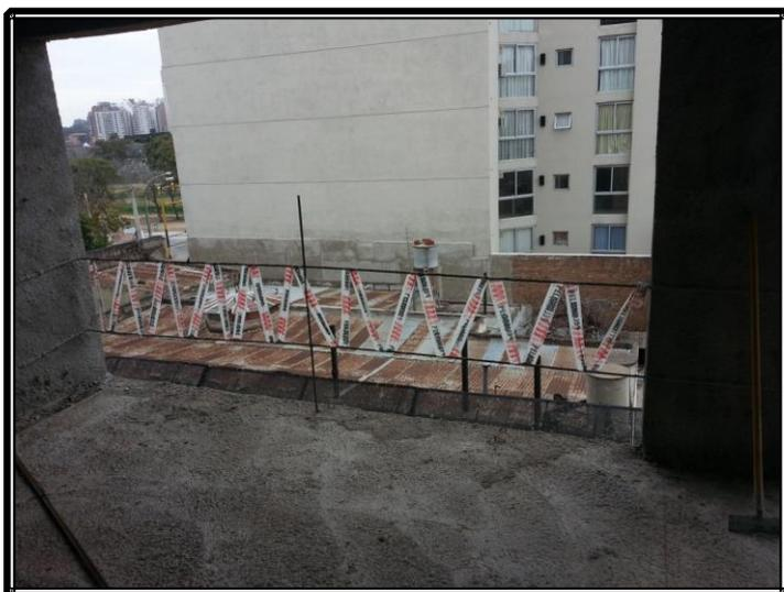
Otra medida tomada fue en las secciones de la circulación vertical, donde se estableció el mismo tipo de vallado pero con la incorporación de una puerta bajo la justificación de que permita aprovechar el espacio para el traslado de materiales de un nivel a otro a través del guinche colocado en el nivel superior de eficiente y manera segura. Ver figura 3.71
