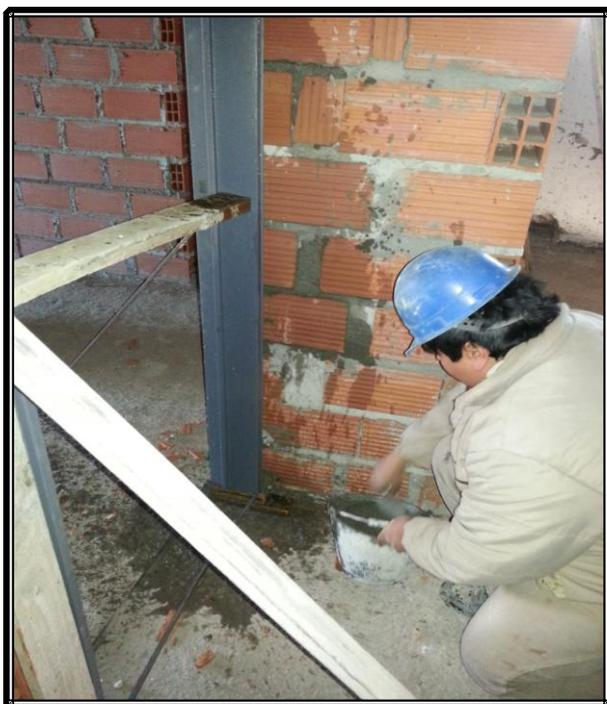
En la siguiente imagen (fig. 3.63) notamos como se colocó un montante en la sección media del marco para evitar que el mismo pueda llegar a deformarse bajo la presión que
