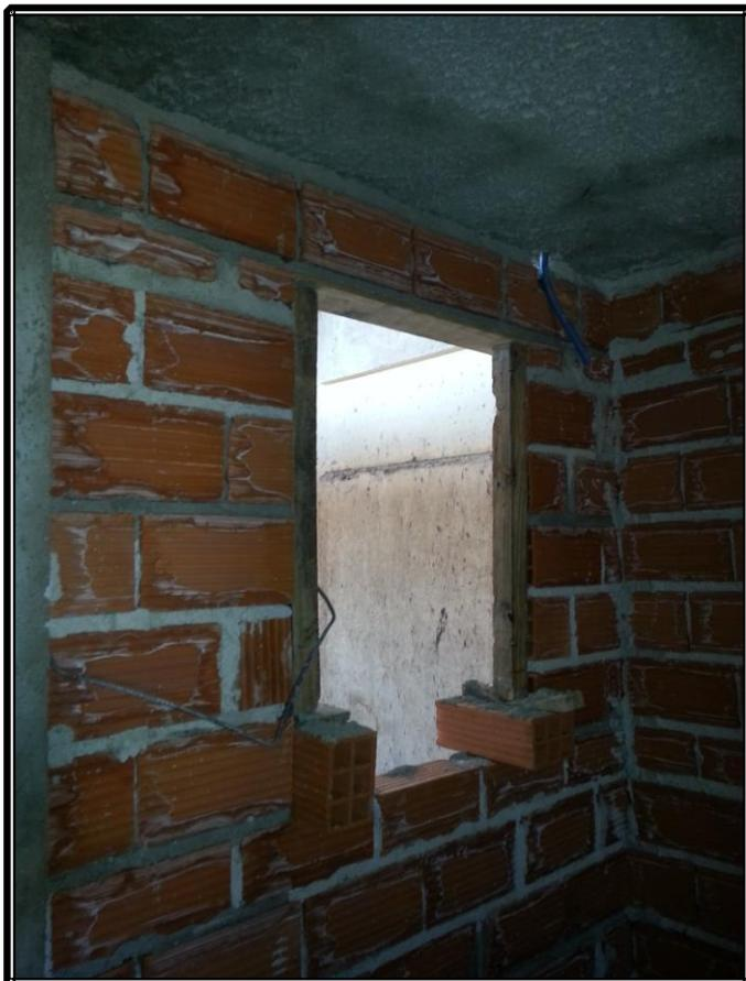
En la imagen anterior fig. 3.55 notamos como se coloca un encofrado para realizar el dintel, al cual se lo asegura con ganchos practicados en obra con sobrantes de secciones de barras de diámetro 8 mm para darle estabilidad al sistema. Lo anterior también permite que sea fácilmente removido en su respectivo momento.
