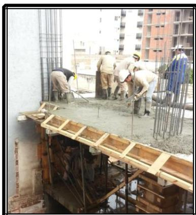
Se muestra a continuación una imagen (fig. 3.41) del ítem final de la tarea del hormigonado, donde culmina en la circulación vertical sobre el encofrado de la escalera, anteriormente mostrado en su apartado. Como se dijo, se postuló que en el plan de distribución del hormigón en estado fresco, este sería el último lugar de llenado, para optimizar la tarea y sus recursos, y evitar que sea maltratado por pisadas de operarios en su posibilidad.
