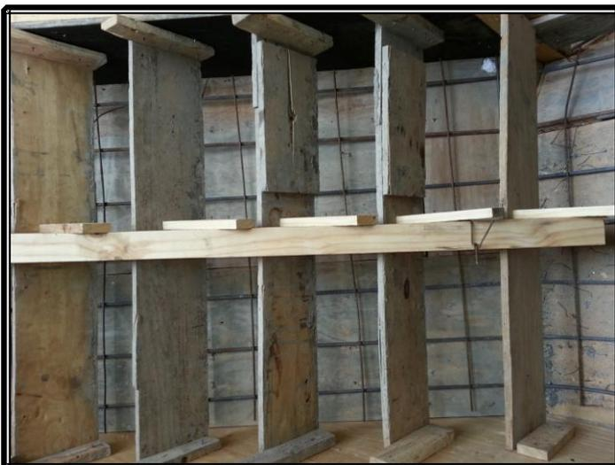
En la siguiente imagen (figura 3.21) vemos como se propuso dejar la armadura inferior de la losa de la escalera como los "pelos" del descanso prolongados hacia la estructura
