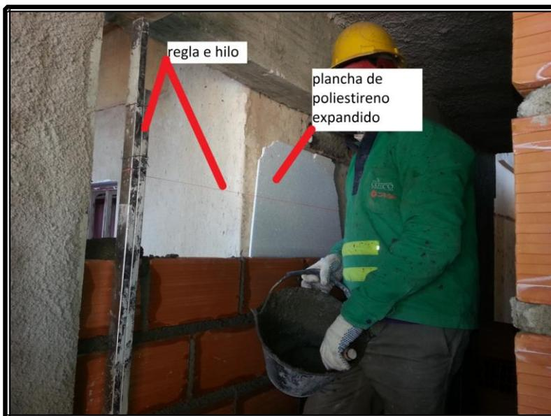
En la siguiente imagen se observa como se practicó el cerramiento del vano de la escalera, el mismo se practica con mortero de asiento cementicio (1:4) dado la presencia de hierros y se utilizan los retazos de ladrillos cerámicos que provienen de los sobrantes en la ejecución de la mampostería de dicho piso.
