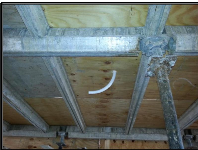
**Fig. 3.3 Vigas principales alineadas con puntales y secundarias en perpendicular.**
