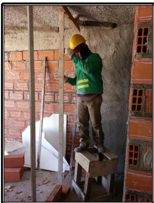
Para la colocación de los mampuestos se utilizó un mortero de asiento 1:1/8:4 elaborado en obra, por lo cual se dividieron los operarios en dos cuadrillas, una de las cuales se ocupaba de abastecimiento de materiales y la otra abocada totalmente a la colocación de los mampuestos.
