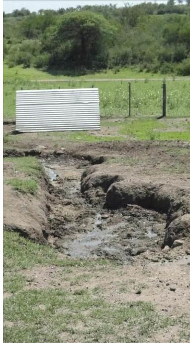
**Figura 19: Efluentes del sistema liberados sin sistematización.**
