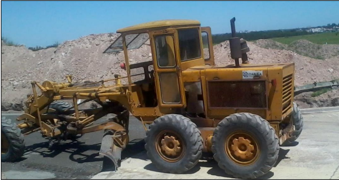
Figura 3.3. Nivelación de la subbase granular
