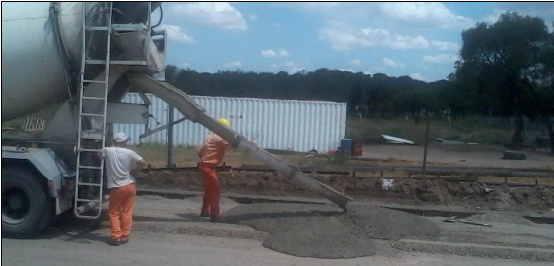
Figura 3.10. Esparcimiento del hormigón para posterior hormigonado del cordón
