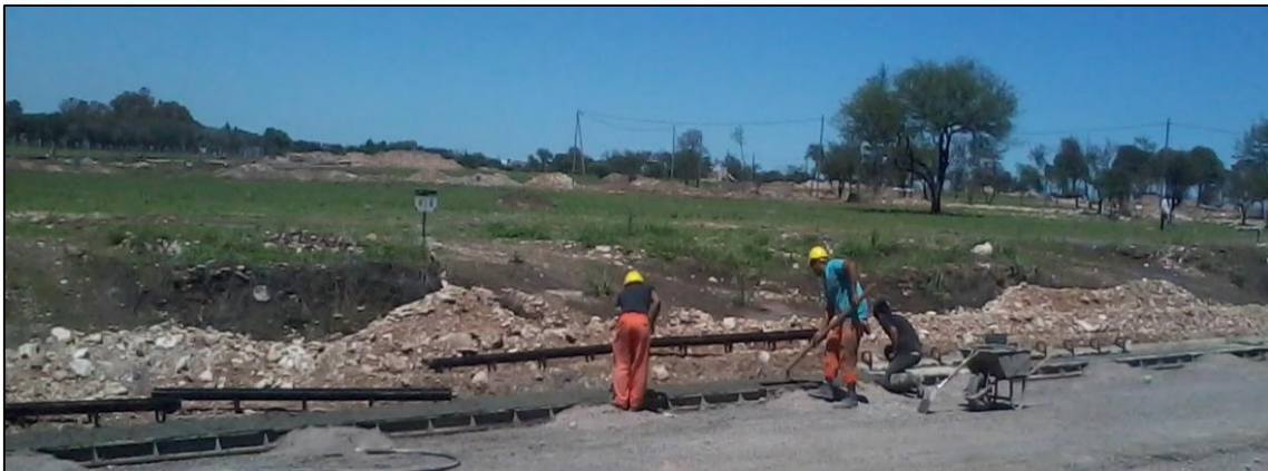
Figura 3.9. Terminación del hormigonado
