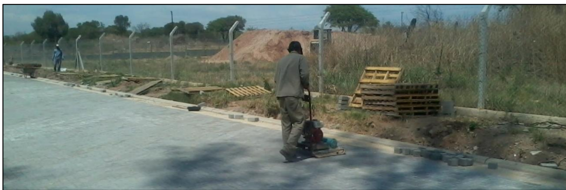
Figura 3.20. Compactación de adoquines
