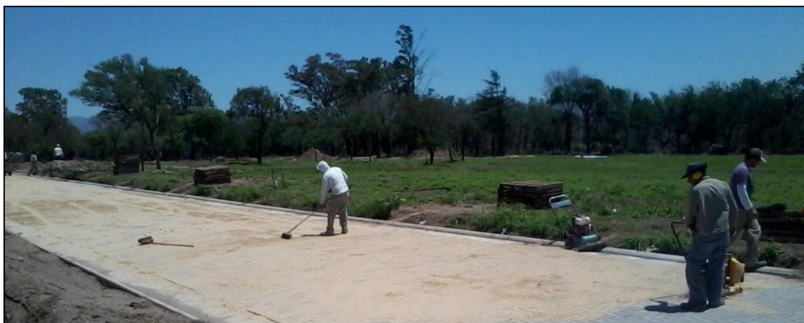
Figura 3.21. Tomado de juntas con arena fina
