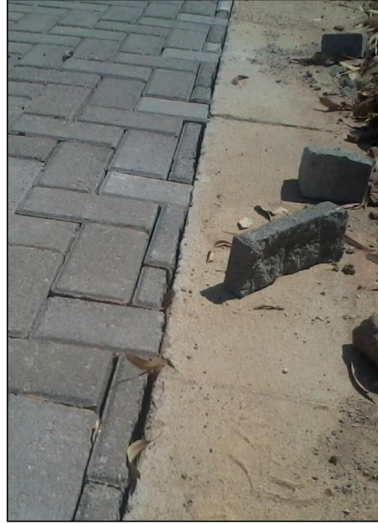
Figura 3.19. Terminación de borde de pavimento
