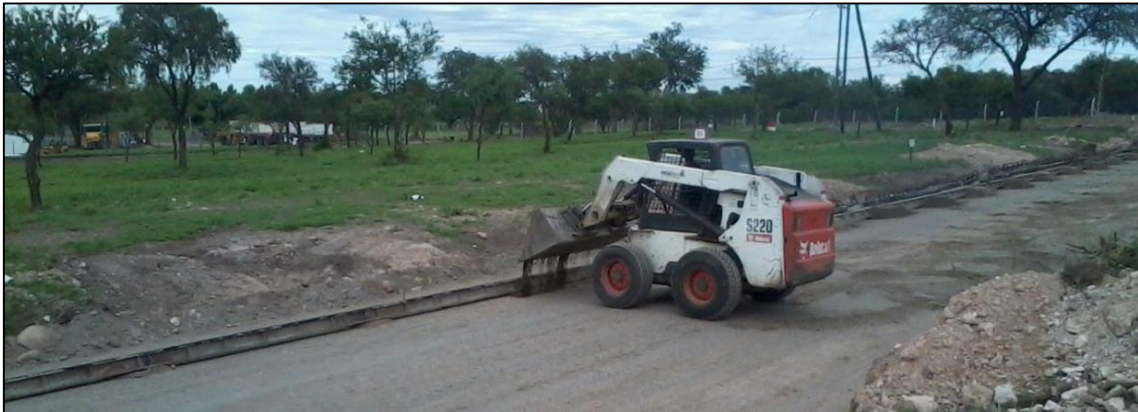
Figura 3.6. Minicargadora colocando material granular en las orillas de los moldes
