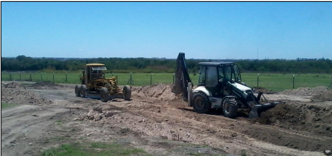
Figura 3.1. Corte y perfilado de la subrasante
