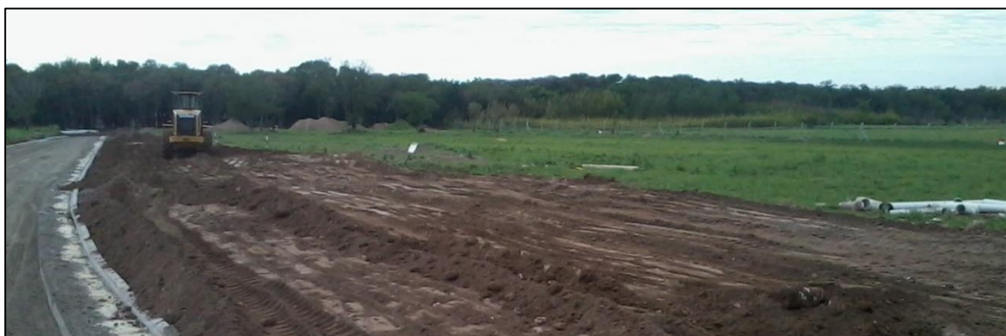
Figura 3.22. Perfilado de veredas
