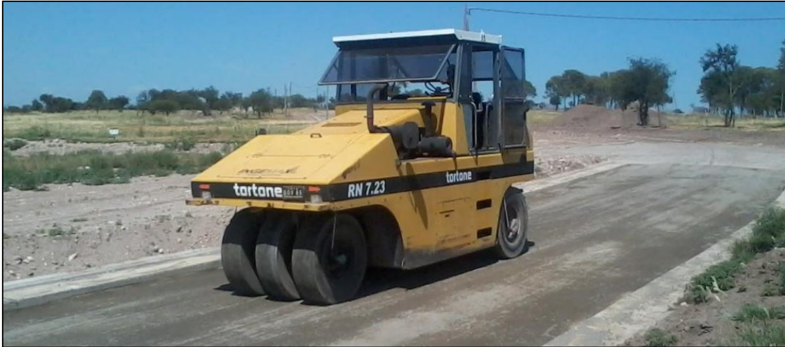
Figura 3.5. Compactación de la subbase granular
