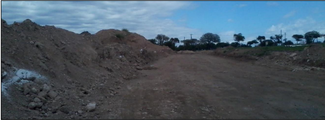
Figura 3.2. Perfil de la subrasante logrado
