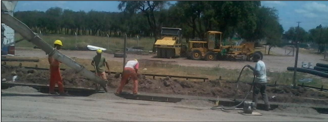
Figura 3.8. Hormigonado de cordón cuneta
