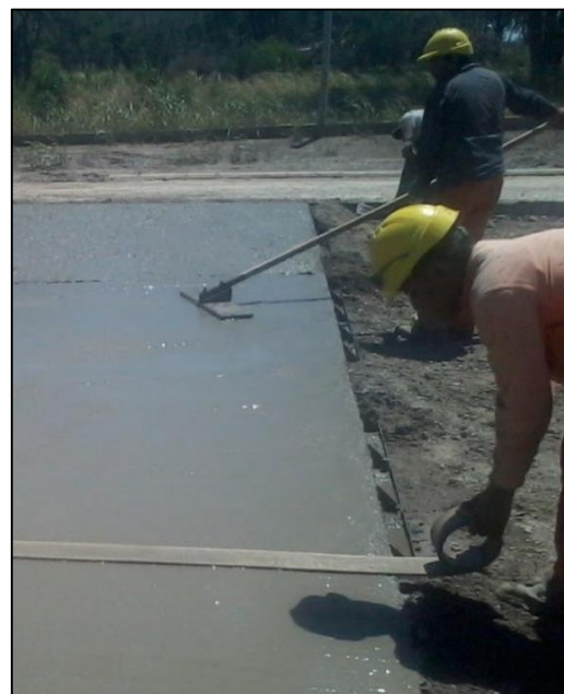
Figura 3.13. Nivelación con cinta para alisar
