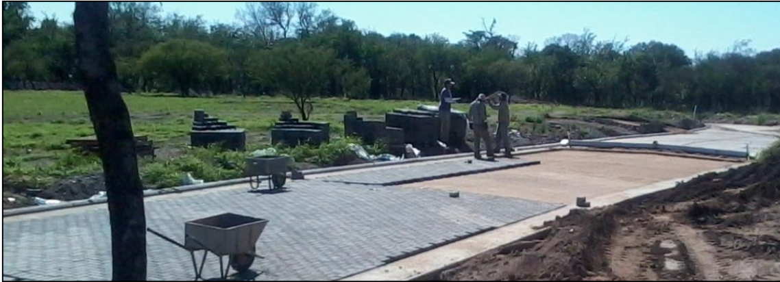
Figura 3.16. Colocación de adoquines mediante “pasamanos”
