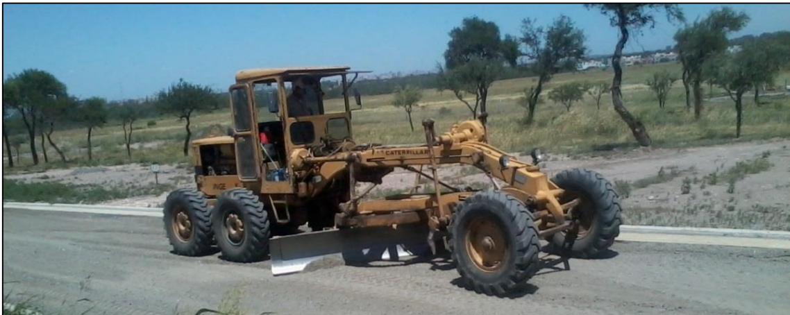
Figura 3.4. Esparcimiento del material granular con motoniveladora
