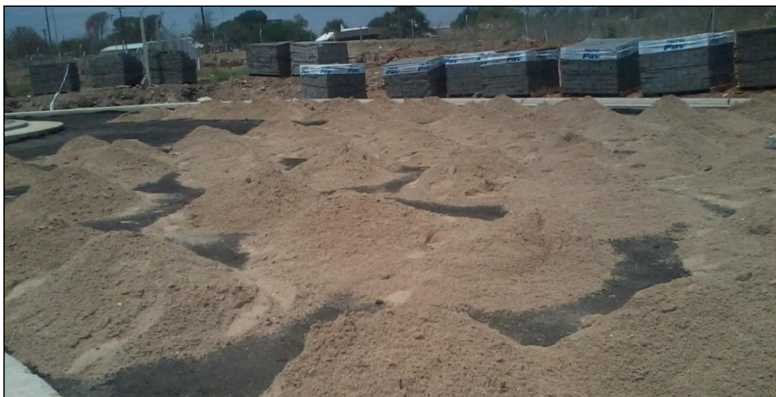
Figura 3.14. Esparcimiento de arena gruesa sobre subbase granular
