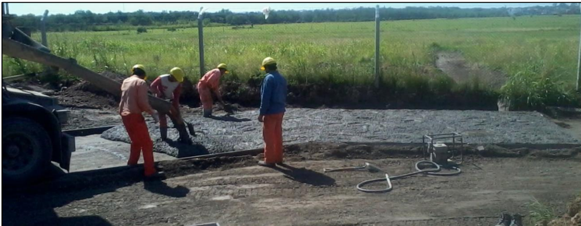
Figura 3.11. Hormigonado de bocacalle
