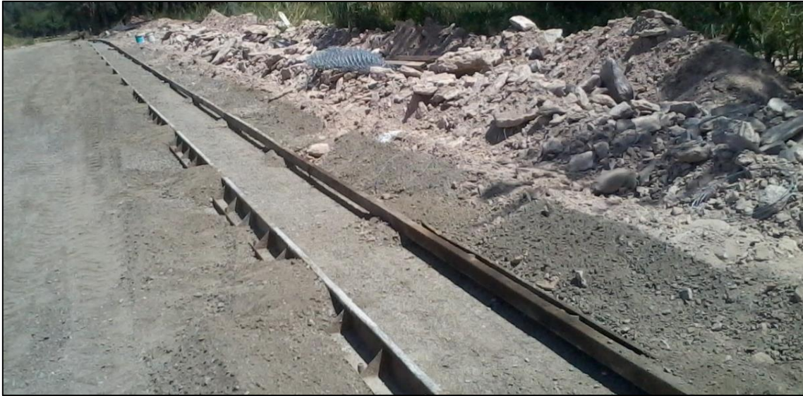
Figura 3.7. Moldes para hormigonar cordón cuneta
