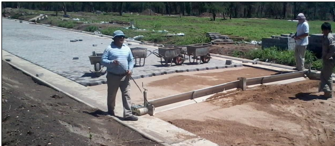
Figura 3.15. Nivelación de arena gruesa
