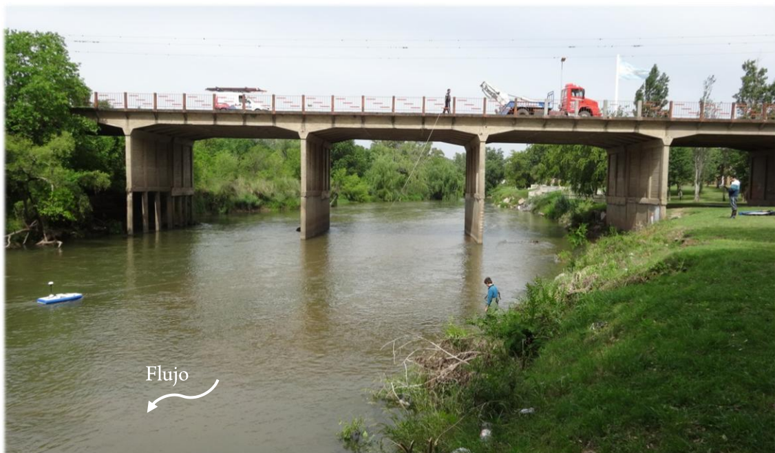
Figura 3.10 - Sección de aforo en el río Tercero ubicada en el puente Lavalle (Villa María).
