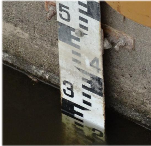
Figura 3.43 - Nivel de agua sobre azud San Marcos.
