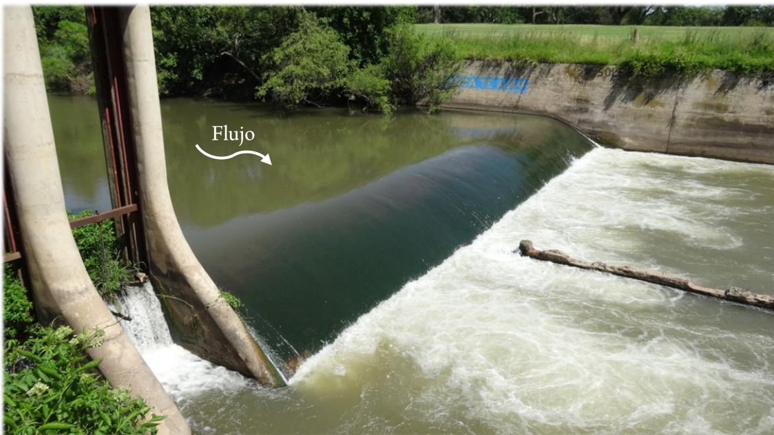
Figura 3.12 - Sección de aforo en el río Tercero ubicada en el azud Bell Ville.
