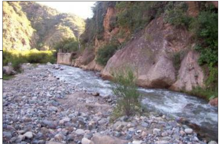
Foto N° 5: Estación La Toma. Vista aguas abajo.
