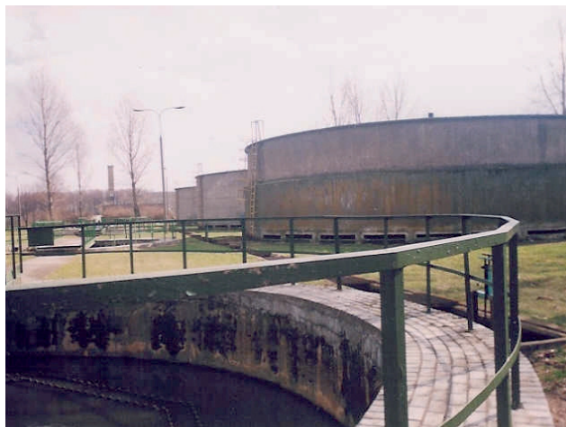
Rys. 11.6. Fragment osadnika wtórnego radialnego oraz złoże biologiczne
