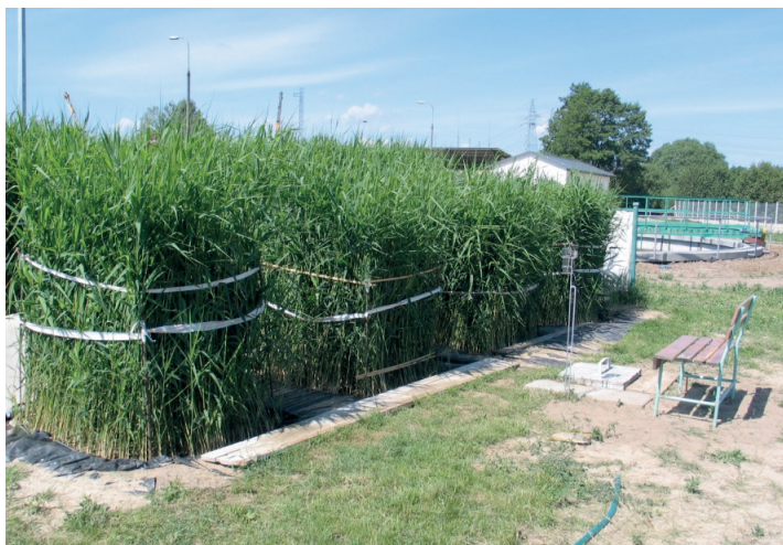
Rys. 11.8. Oczyszczalnia roślinna z filtrem trzcinowym jako trzeci stopień oczyszczania ścieków
