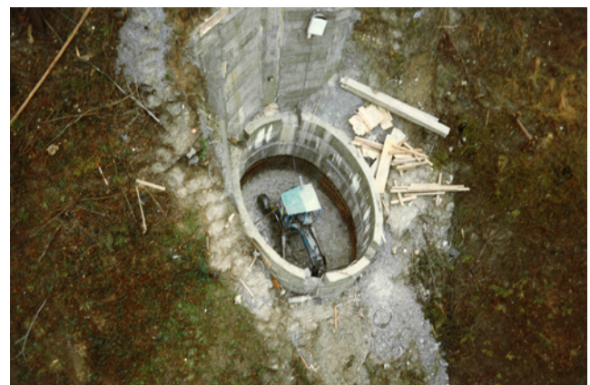
Abb. 2: Aushub eines Gründungsschutzschachtes mit einem elektrisch betriebenen Schreitbagger. Foto: J. Gasser, April 1980.
