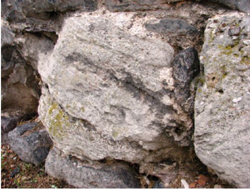
Abb. 8: In Mineralbestand und Gefüge sowie der Qualität der Bearbeitung deutlich von den überwiegend verbauten Sandsteinquadern abweichende tertiäre Sandsteine. Intensive Wechsellagerung von feinsandigen bis grobkiesigem Material, häufig treten die weißen kretazischen Kalkklasten hervor. Am oberen Bildrand der feinkörnige graue Höör-Sandstein.
