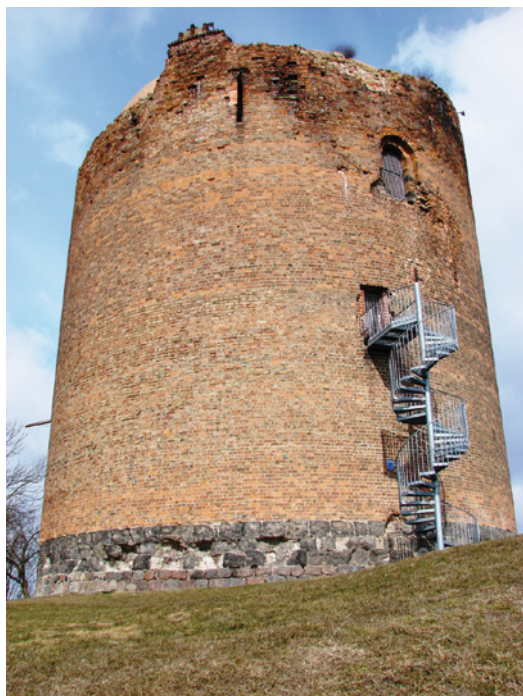
Abb. 2: Gesamtansicht des Stolper Turmes („Der Grütz-pott“). Die Öffnung oberhalb der Treppe ist der ursprüngliche Eingang. Direkt über dem Bodenniveau sind zwei bis drei Reihen behauener Feldsteine erkennbar, darüber drei Reihen behauener Sandsteine. Der größte Teil des Turms ist aus Backstein errichtet.
