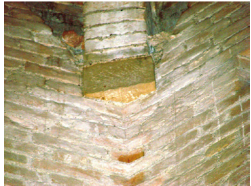
Abb. 6: Blick im Inneren des Turms auf die Bandripenkuppe und das Angstloch mit einem Rand aus Sandstein.
