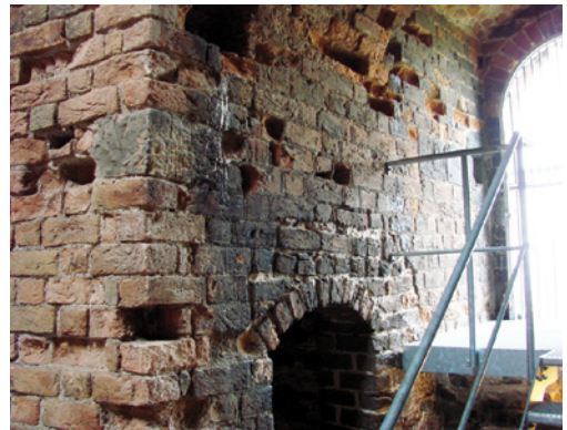
Abb. 9: Im Inneren im Backsteinmauerwerk versetzte feinkörnige Höör-Sandsteine als Ecksteine und U-förmiger Stein am ursprünglichen Ausgang.
