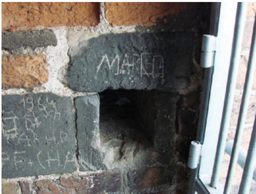
Abb. 9: Im Inneren im Backsteinmauerwerk versetzte feinkörnige Höör-Sandsteine als Ecksteine und U-förmiger Stein am ursprünglichen Ausgang.
