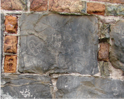
Abb. 4: Vereinzelt wurden Backsteine als Ausgleichslagen zwischen die Sandsteinblöcke gefügt. Am oberen Rand des Quaders aus Sandstein steht der Mörtel ca. 1 cm mit dem Backstein hervor, dies dokumentiert die Rate der Abtragung an der Oberfläche (außen, NW-Lage).
