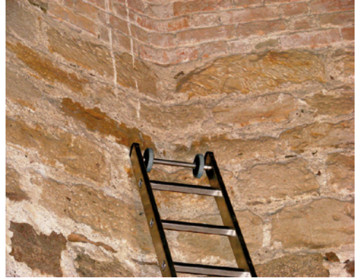
Abb. 4: Vereinzelt wurden Backsteine als Ausgleichslagen zwischen die Sandsteinblöcke gefügt. Am oberen Rand des Quaders aus Sandstein steht der Mörtel ca. 1 cm mit dem Backstein hervor, dies dokumentiert die Rate der Abtragung an der Oberfläche (außen, NW-Lage).
