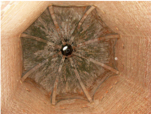
Abb. 6: Blick im Inneren des Turms auf die Bandripenkuppe und das Angstloch mit einem Rand aus Sandstein.
