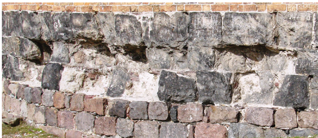
Abb. 3: Detailaufnahme des Natursteinmauerwerkes (außen). Deutlich ist das Bemühen, die Stoßfugen um jeweils einen halben Stein zu versetzen. Um dies zu erreichen wurden oft schmale Ergänzungssteine aus plattig spaltendem Material in die Stoßfuge eingesetzt; der Bereich zeigt durch Kriegsbeschädigungen einen Einblick in das Mauerwerksinnere.
