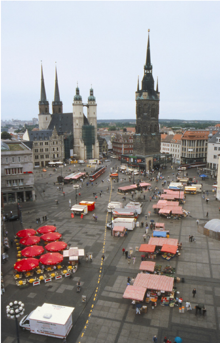
Abb. 3: Marktplatz von Halle. Die gelbe Linie markiert den Verlauf der Halle-Störung
