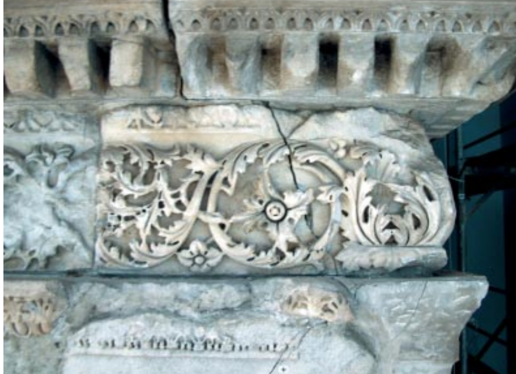
Abbildung 6: Rissbildungen und Auflockerungszonen in konstruktiv brisanten Positionen
