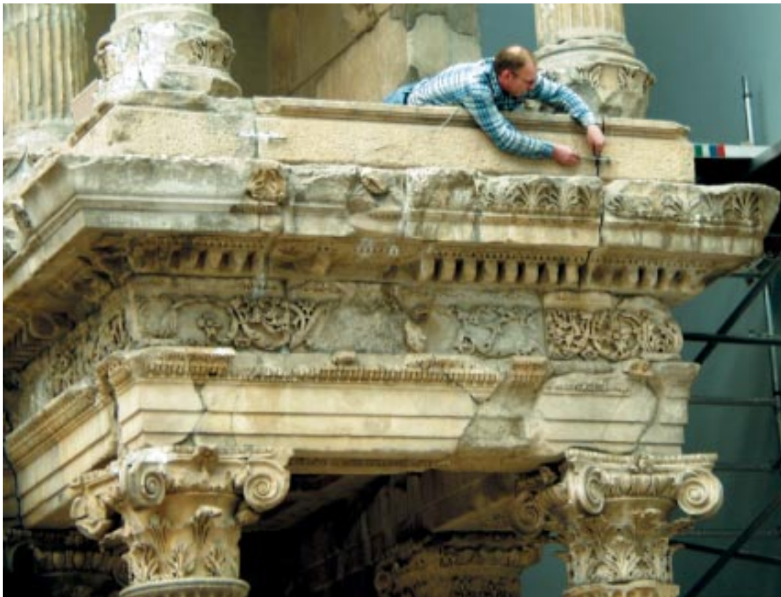
Abbildung 5: Dehnungsmesser zur Überprüfung der Bewegungen an statisch brisanten Rissen
