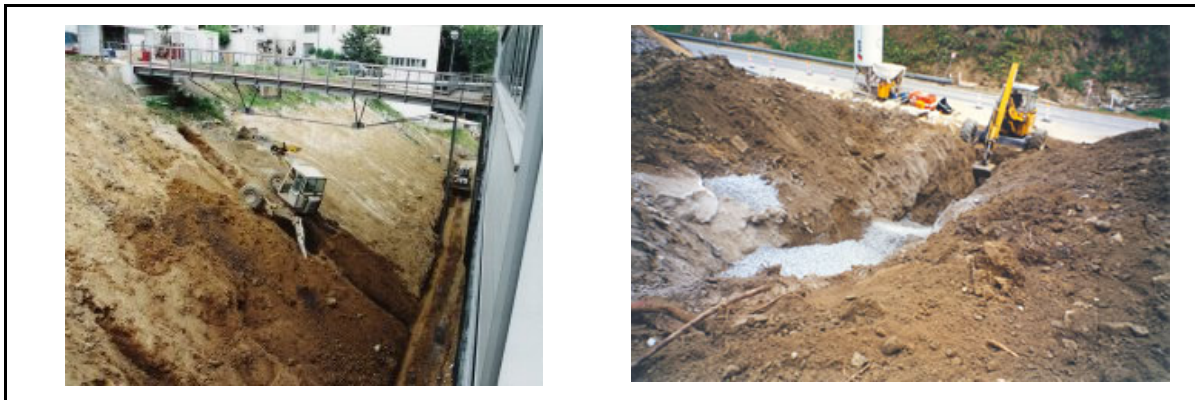
Abbildung 3 Herstellung der Erdbetonstützscheiben mit dem Schreitbagger (Fotos: Firma SIDLA & SCHÖNBERGER)
