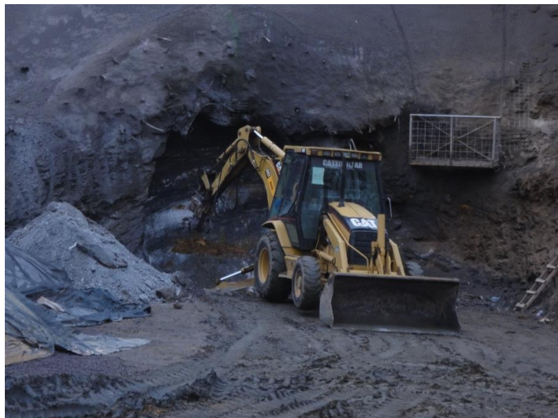
Foto 13, Retroexcavadora; Maquina Motriz
