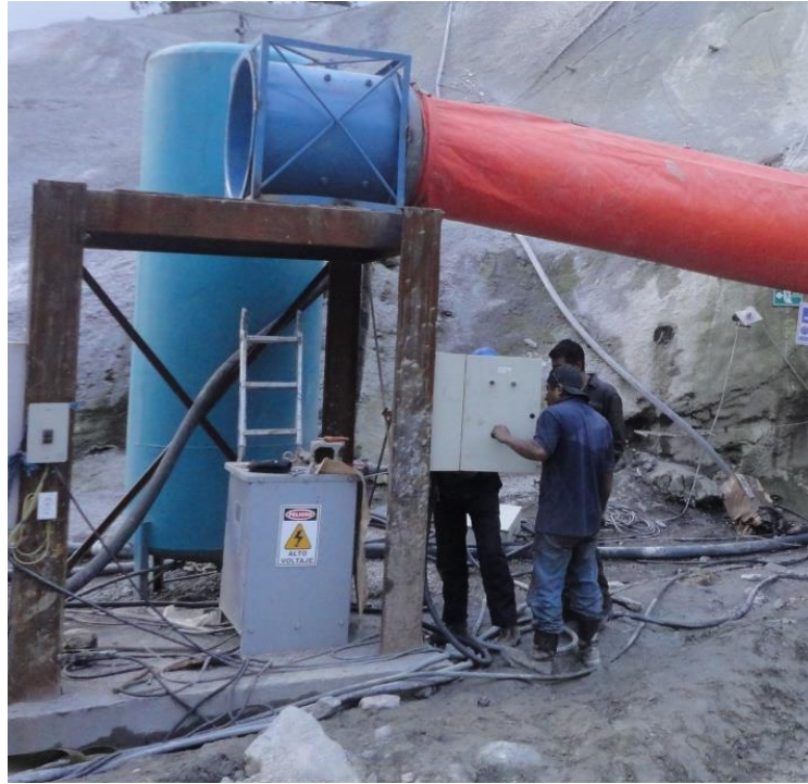
Foto 6, Instalación eléctrica para ventilador.
