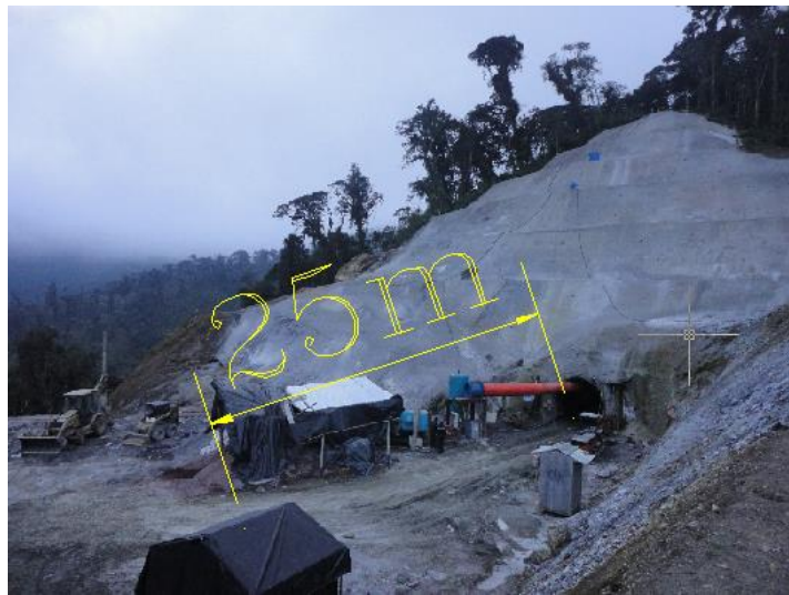
Foto 1, Ubicación Auxiliar Túnel.
