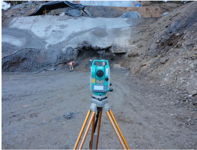
Foto 16, Alineación y nivel Túnel.
