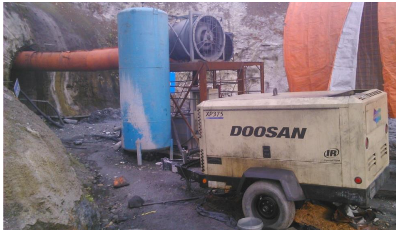
Foto 8, Compresor y Pulmón de aire.
