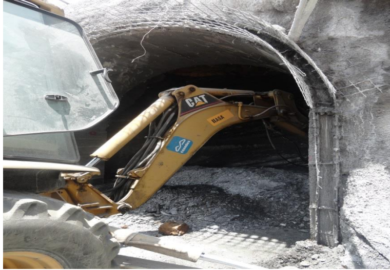
Foto 15, Excavación con fresadora.
