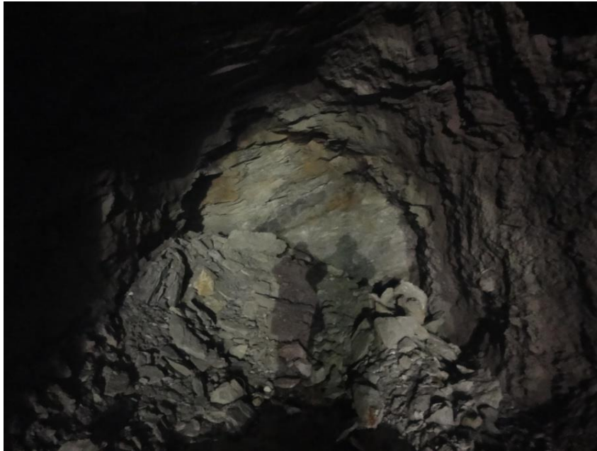
Foto 24, Material producto de la voladura a rezagar.
