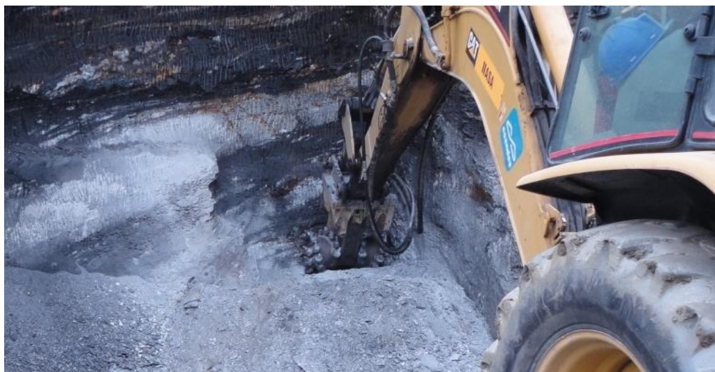
Foto 12, Excavación con fresadora.
