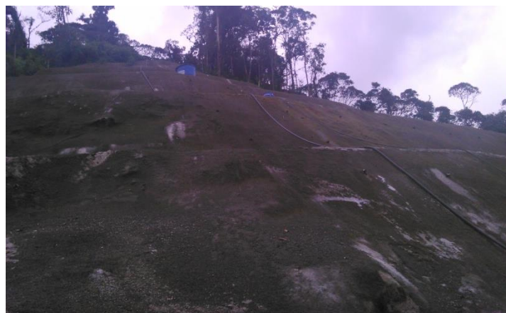
Foto 9, Tanque de agua en taludes del portal de salida del Túnel
