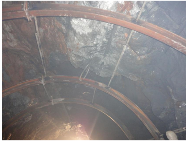
Foto 25, Colocación de soportes Acero (Cerchas).
