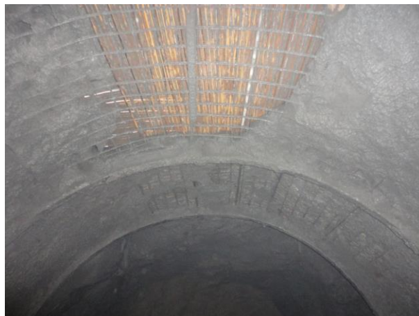
Foto 26, Hormigón Lanzado e=0.20\text{ m}
