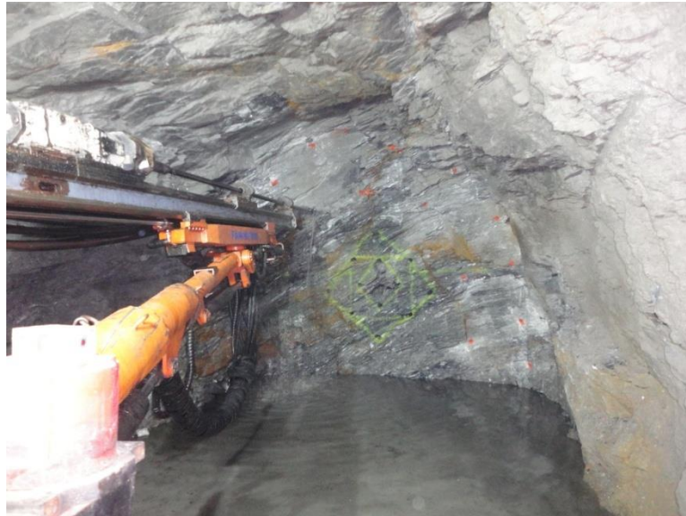
Foto 19, Perforación realizada en el túnel de Conducción
