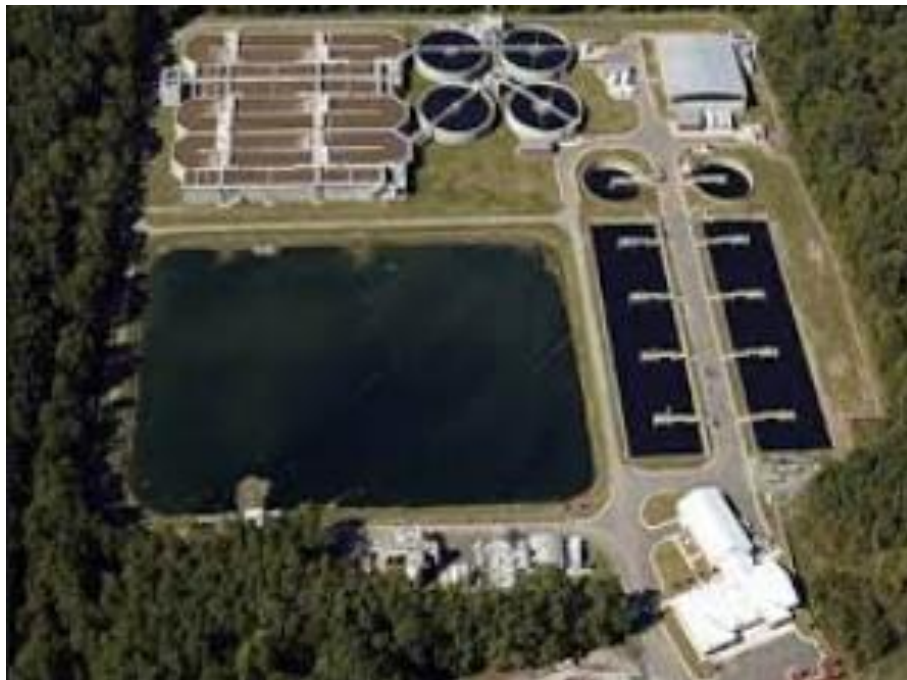
FIGURA 2.6. PLANTA DE TRATAMIENTO DE AGUAS RESIDUALES
