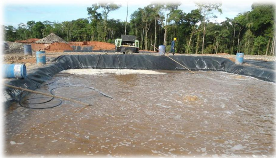
Figura M 6. Dosificación de Poliacrilamida
