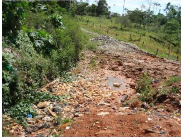
Figura 39. Acumulación de aguas lluvia en las celdas.
