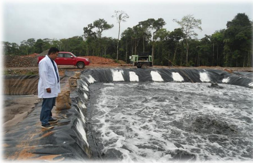
Figura M 3. Dosificación de Cal en la piscina 2.
