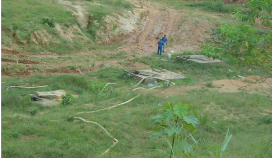
Figura 30. Cisternas para almacenamiento de Lixiviados.
