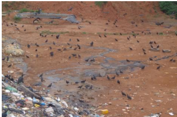
Figura 35. Infiltración de lixiviados en el Domo 2.
