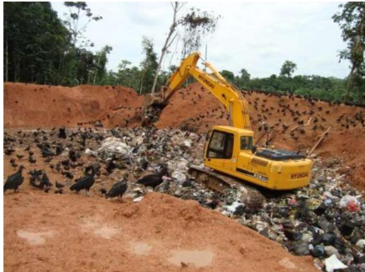
Figura 29. Acomodación mecánica de residuos sólidos en el Domo 2
