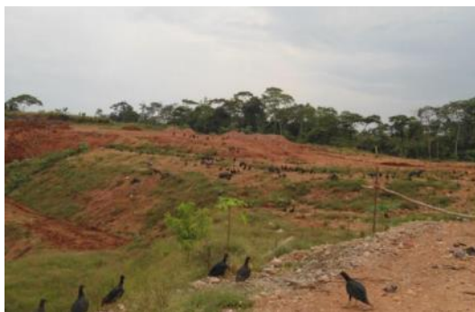
Figura 26. Domo 1. Para la disposición final de residuos sólidos completamente cubierto.
